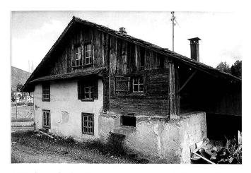
4: Rückansicht des Hauses. Gemauerter Sockel mit darüberliegender Kammer in Ständerbohlenbauweise. Blick nach Südosten.
