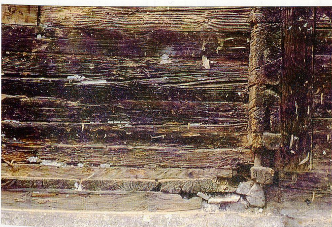
2: Südöstliche Ecke des erhaltenen Teils des Kernbaus. Sichtbar sind die fassadenbündigen Bodenbohlen und das Schwellenschloss. Rechts fügt sich der Anbau des 19. Jh. an. Blick nach Norden.
