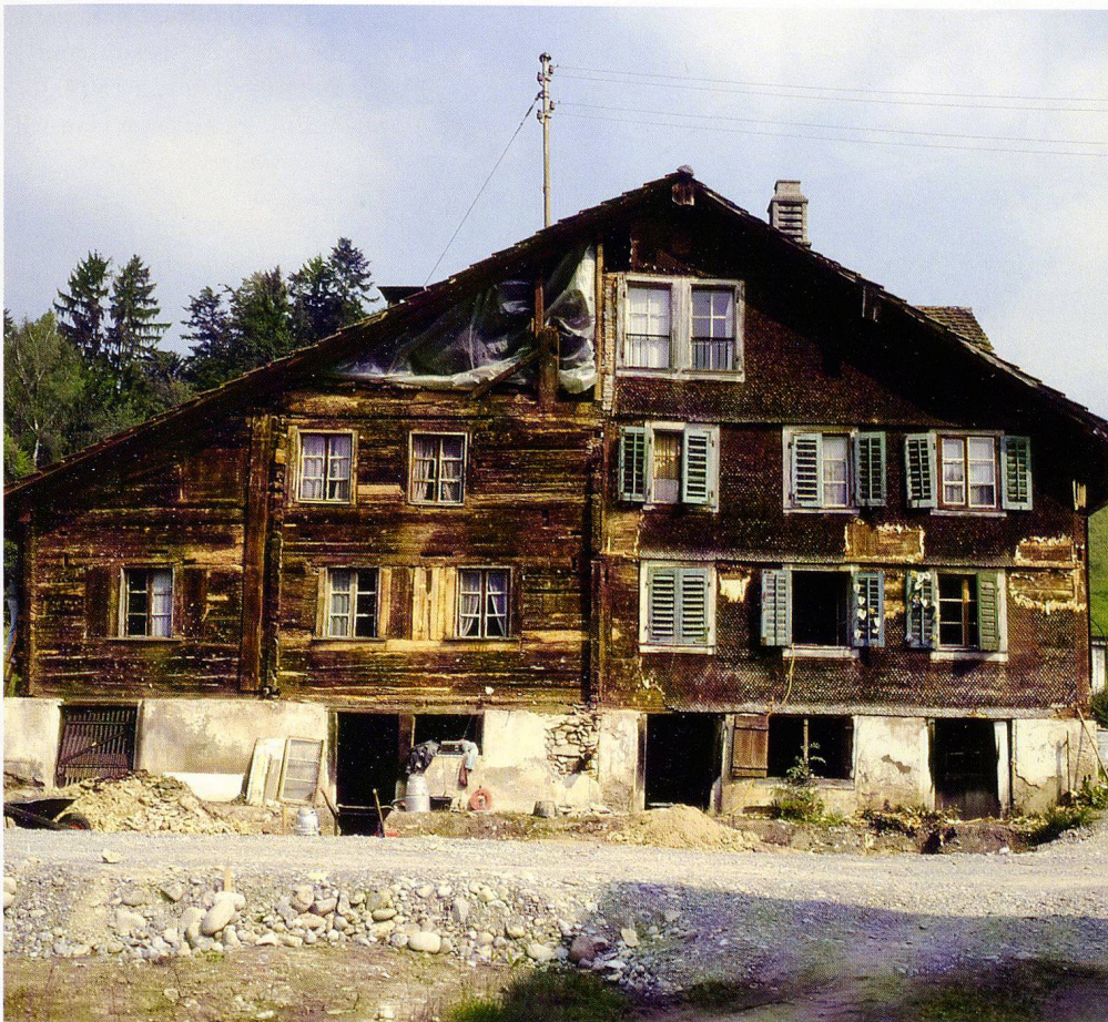
1: Die Südfassade des Hauses «Weid». In der Mitte der Kernbau, links der frühneuezeitliche Anbau, rechts der im 19. Jh. erichtete Hausteil.
