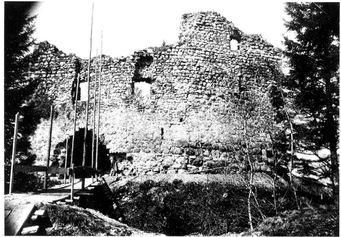
8: Burgruine Nüegg Lieli. Südansicht der Ruine kurz vor Beginn der Sanierungsarbeiten 1930/31.
