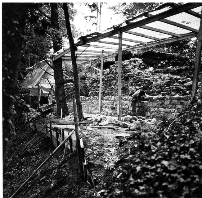
15: Die Ruine Schenkon während den Sanierungsarbeiten 1992.
