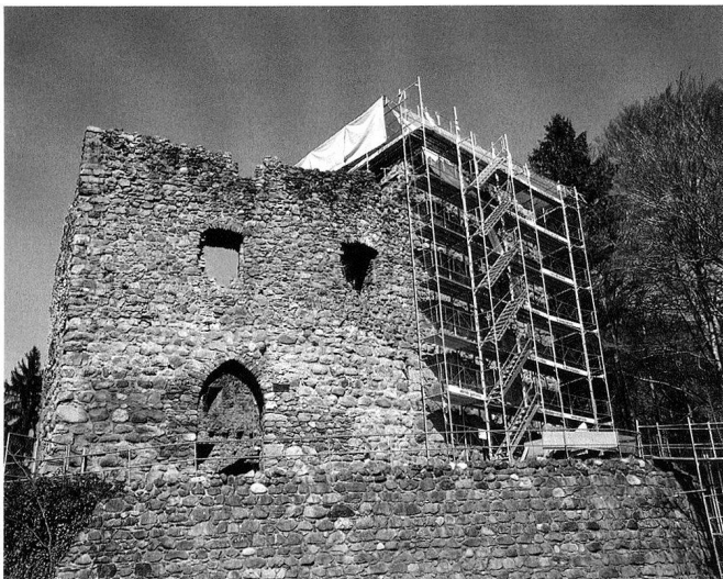
16: Die Burgruine Nüegg bei Lieli während der momentan laufenden Sicherung des vom Einsturz bedrohten Bauwerks.
