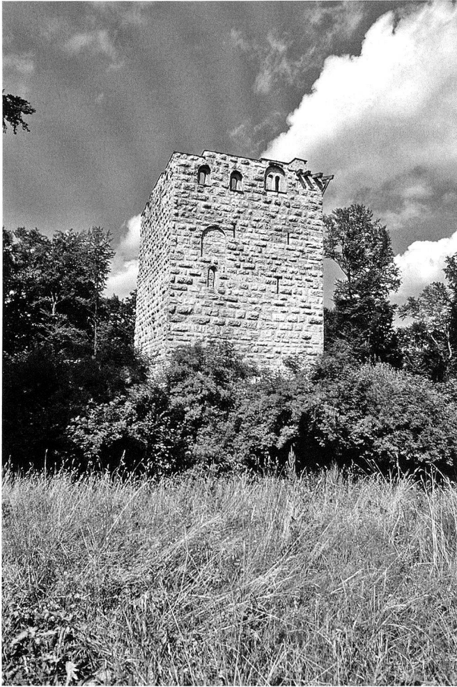
19: Ruine Kastelen bei Alberswil. Der imposante Burgturm in frisch saniertem Zustand 2002.
