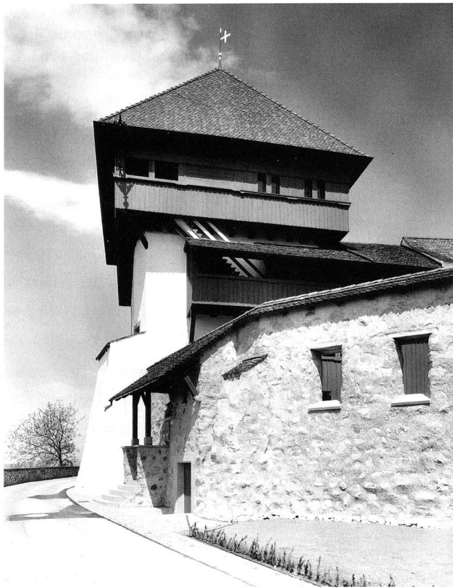
13: Ehemalige Johanniterkommende Hohenrain. Der sog. Turm «Roten» nach der umfassenden Renovation 1984.
