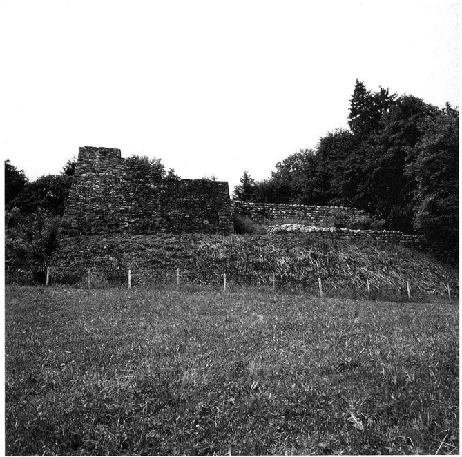
3: Burg Oberrinach bei Römerswil, Blick von Osten. Zustand der Anlage 1991 nach den letzten grösseren Sanierungsmassnahmen.
