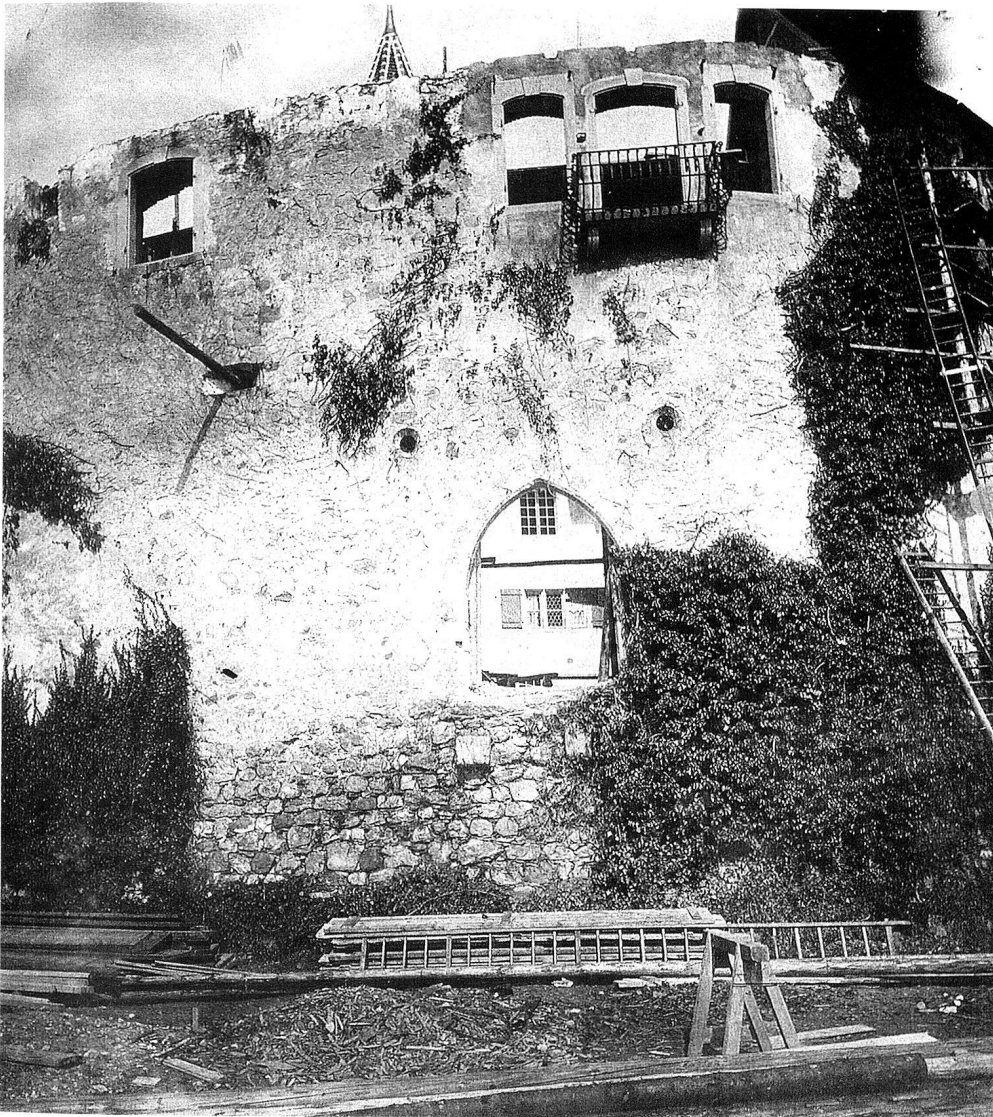
7: Schloss St. Andreas. Das ursprünglich mit einer Zugbrücke ausgestattete Südtor wurde erst zu Beginn des 20. Jhs. zugemauert. Umbauarbeiten unter Fred Page und Dagobert Keiser. Foto 1908.
