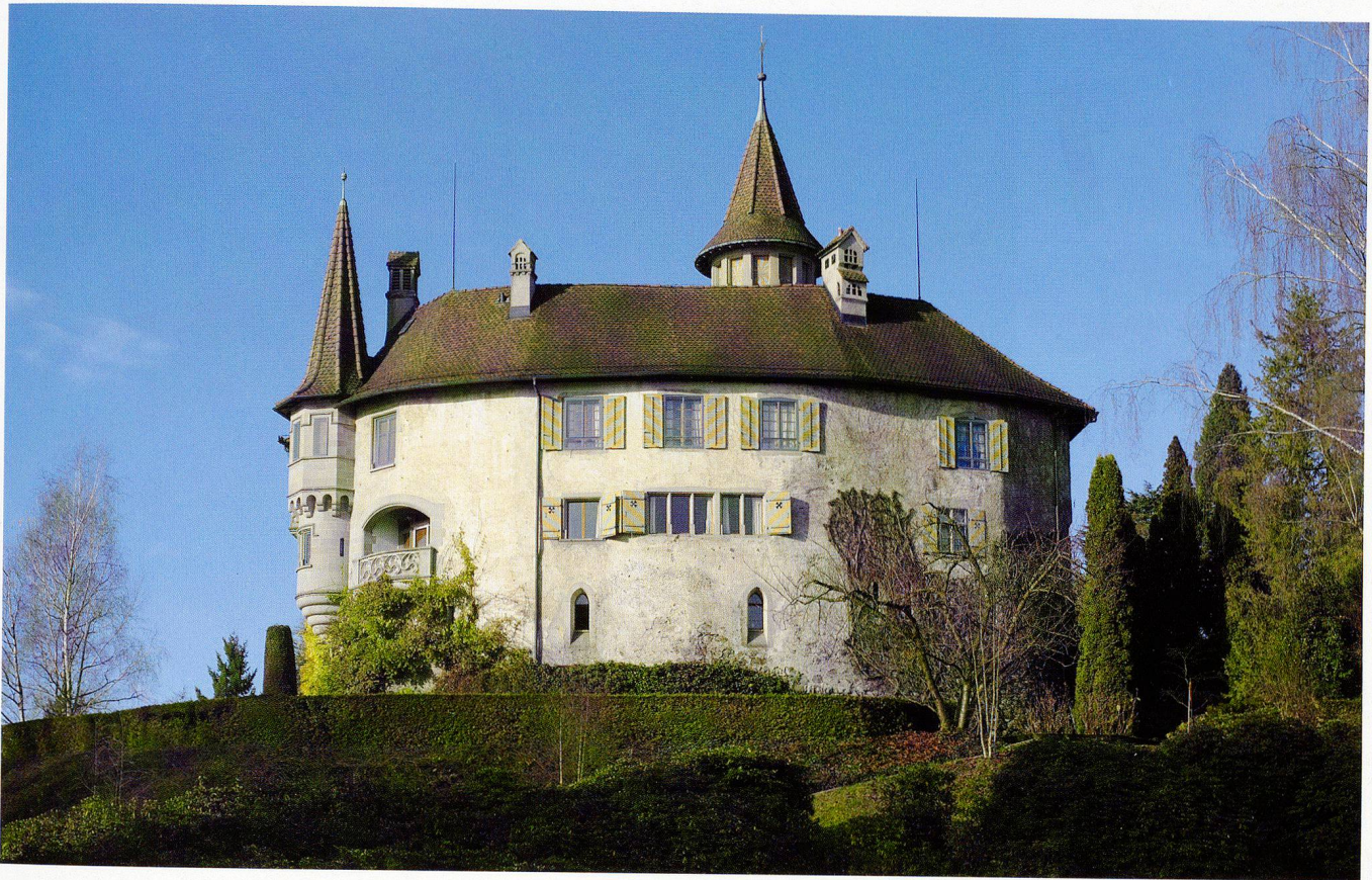
Tafel 1a: Schloss St. Andreas. Ansicht der Süd- und Ostfassade. Foto 2009.
