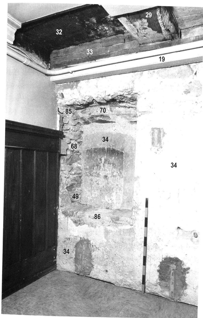
9: Schloss St. Andreas. Erdgeschoss, Raum 0.17. Nordwestecke mit zugemauerter Wandnische. Foto 2009.
