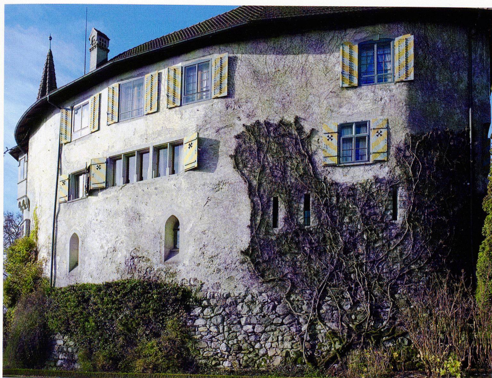
Tafel 3a: Schloss St. Andreas. Ansicht der Ostfassade mit unverputzt belassener Mantel- mauer. Foto 2009.
