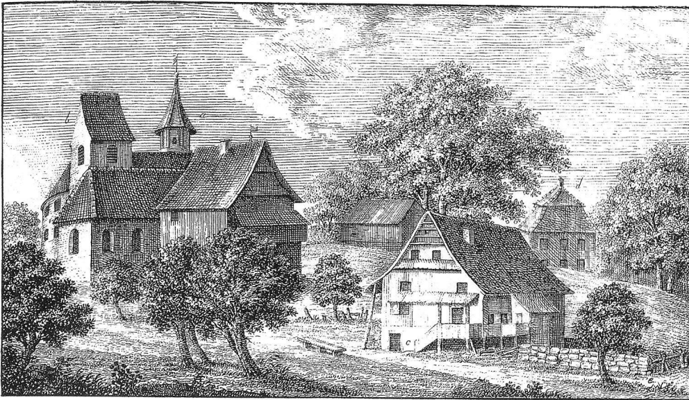
8: «Die Burg S. Andres v. ihrer Nord-Ost-Seite». Links im Bild die Schlosskapelle St. Andreas, dahinter sind ein Teil der Mantelmauer und der im 17. Jh. erbaute Treppenturm zu sehen, auf der rechten Bildseite das als Kaplanei errichtete Turmhaus und Mauerreste des ehemaligen Torturms. Lithografie Johann Kaspar Moos zugeschrieben, 1819.
