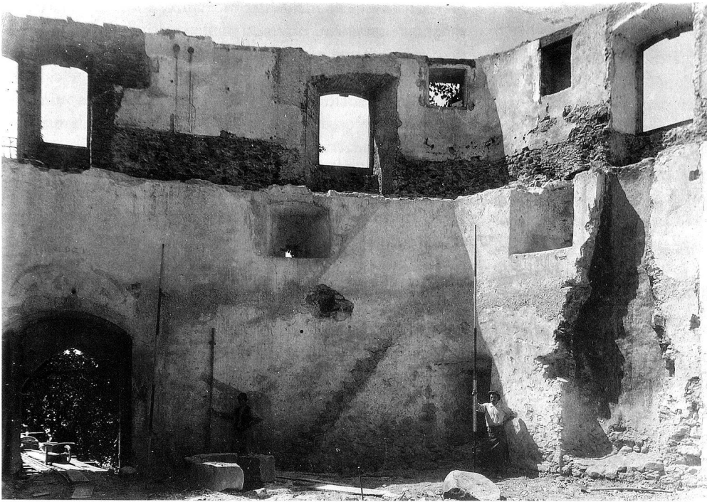
10: Schloss St. Andreas. Zustand während der Umbauarbeiten zu Beginn des 20. Jh. Foto 1908.
