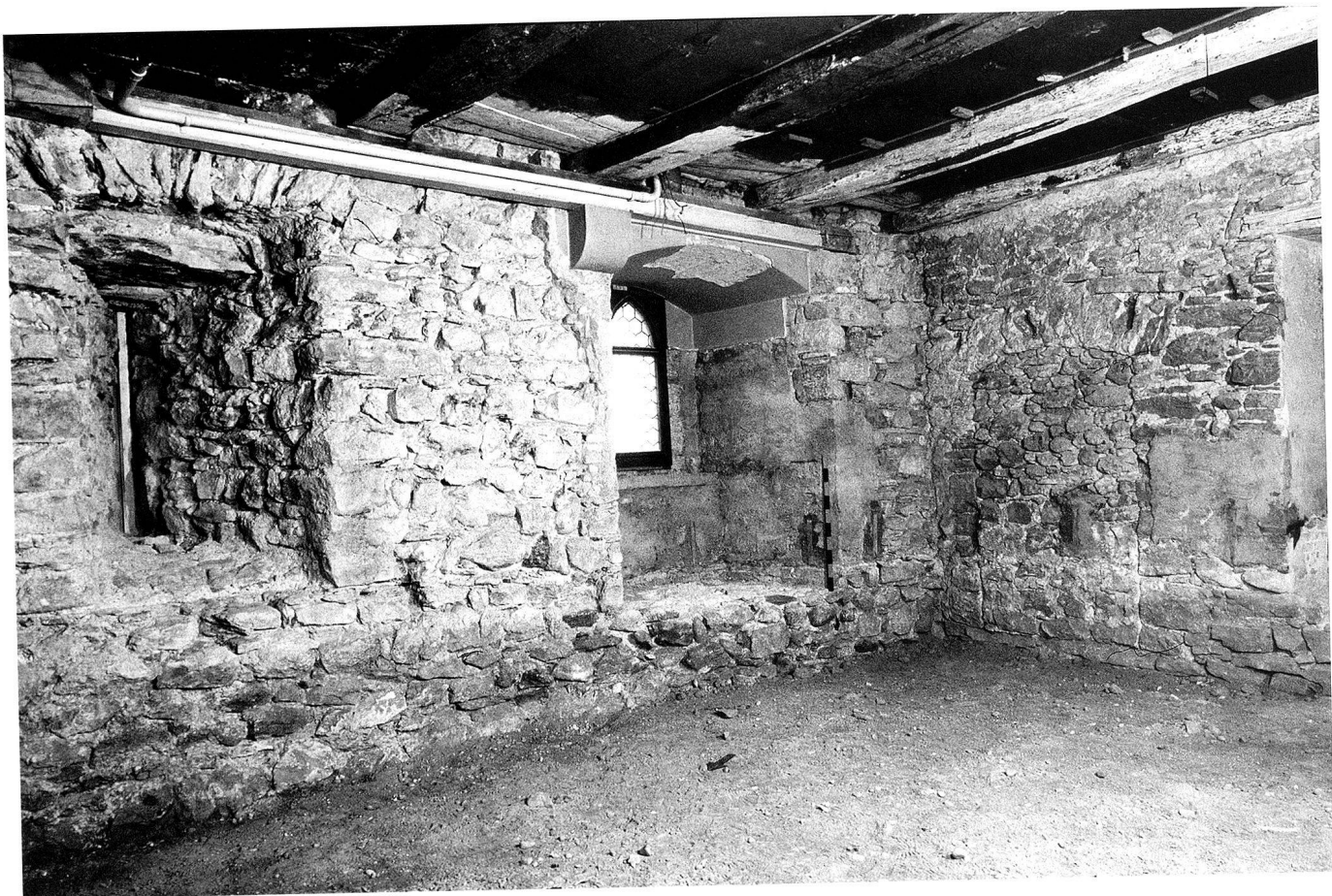
5: Schloss St. Andreas. Erdgeschoss, Räume 0.16 und 0.17. Ansicht an die Mantelmauer mit originalem Schlitzfenster und die südliche Gebäudemauer mit zugemauerter Türöffnung. Foto 2010.
