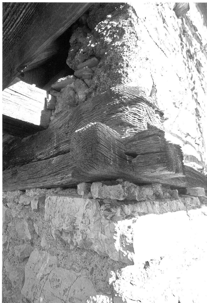
7: Überkämmt Kronbalken an der Südecke des Palas, vermutlich Auflager des Obergadens von 1375/1380, darüber Mauerschwellen des Dachstuhls von 1620–1622.
