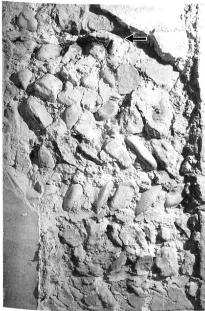
24: Kernbau I, Mauerkrone 4.4 von O.
