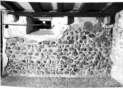
30: Kernbau III, Keller. N-Mauer 12.
