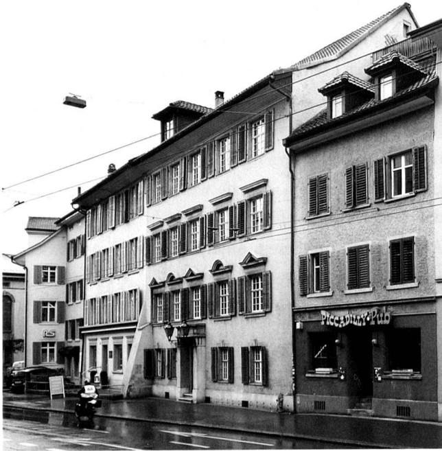
1: Technikumstrasse 68 von Südosten. An den sog. «Bauhof» in der Bildmitte schliesst rechts das Haus Nr. 66 an. Links springt die Nr. 74/76 aus der Hauszeile vor.
