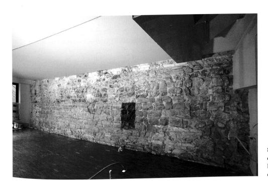
8: West-Innenmauer des Kernbaus II (9) mit der Fensterscharte (9.2) nach dem Umbau.
