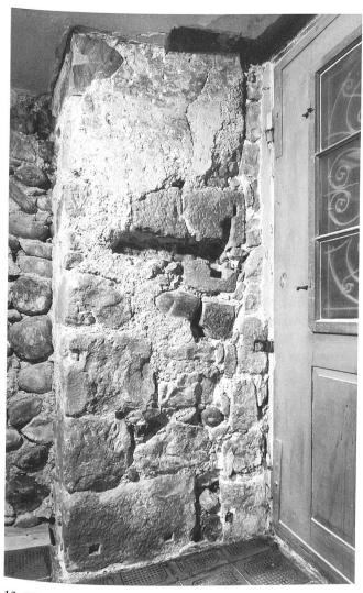
12: Westliches Gewände der Türe (18.1) mit den Verschlusseinrichtungen. Deutlich erkennbar ist aufgrund des Schattenwurfs der horizontale Balkenrast.
