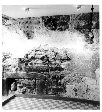
4: West-Innenmauer des Kernbaus I (4) nach dem Umbau. Über dem seit 1343 (d) beibehaltenem Bodenniveau befindet sich das teilweise freigelegte Fenster (4.1). Der Pfeil in der Bildecke oben rechts markiert die Nordflucht, welche die Brandspuren (10.1) aufwies. Auf der Wandfläche sind Verputzreste des Umbaus von 1343 (d) (16) erhalten.
