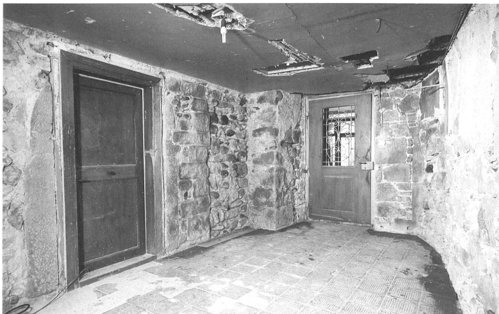
11: Erdgeschoss der Nord-Erweiterung von 1343 (d) des Kernbaus III von Süden. Linkerhand befindet sich der Kernbau I (4) mit der nachträglich eingebrochenen Türe (16.6). Daran schliesst die Mauer (16) an, an welche die Nordost-Fassade (18) mit der Türe (18.1) stösst. Die Binnenmauer (20) rechterhand entstand frühestens 1469 (d).
