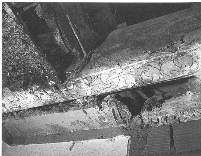
13: Westlicher Hausteil, 1. Obergeschoss. Ansicht der mit Flachschnitzerei verzierten Deckenbalken (21) von unten. Der zweite Balken befindet sich über den Backsteinen. Dazwischen ist eine unverzierte Bohle eingeschoben.
