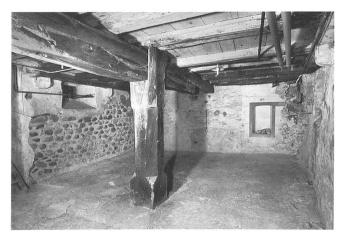
9: Keller im Kernbau III (1317 d) nach Nordosten. Original sind Stud, Sattelholz und Unterzug (12.4) sowie der Mörtelboden (12.2). Linkerhand ist die gleichzeitig errichtete Nordwand (12) sichtbar. Rechts verlief die Stadtmauer (7), die wie die Mauer des Kernbaus II (9) unterfangen wurde.
