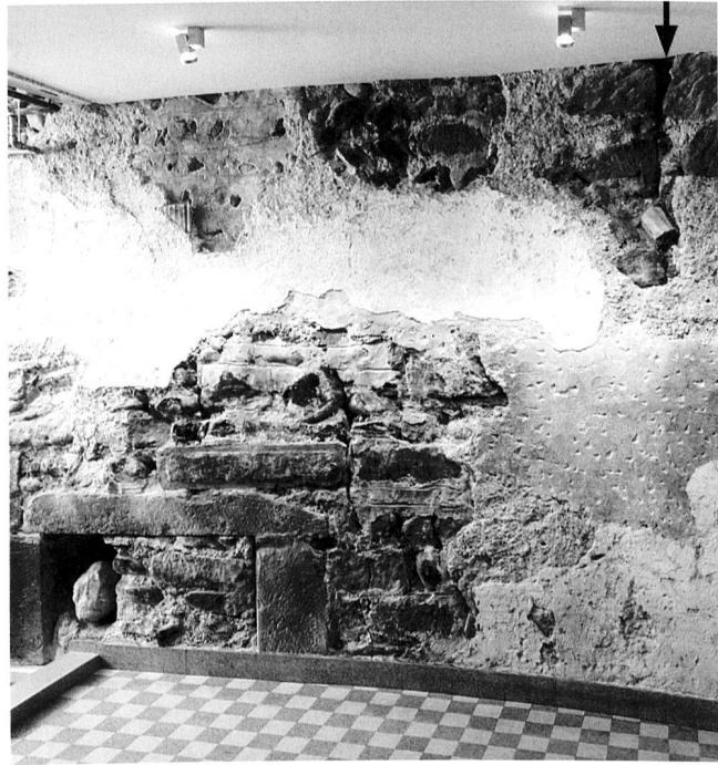
4: West-Innenmauer des Kernbaus I (4) nach dem Umbau. Über dem seit 1343 (d) beibehaltenem Bodenniveau befindet sich das teilweise freigelegte Fenster (4.1). Der Pfeil in der Bildecke oben rechts markiert die Nordflucht, welche die Brandspuren (10.1) aufwies. Auf der Wandfläche sind Verputzreste des Umbaus von 1343 (d) (16) erhalten.
