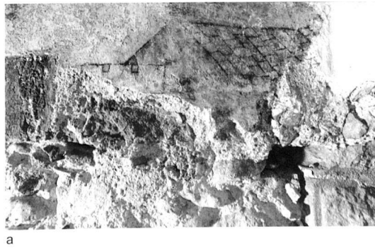
14: Kellerabgang. Die Malerei (26) entstand, als der Kellerabgang noch 2,2 m tiefer lag (16.1). Die Nordfassade (16) und die Kellerabgangsmauer (17/25) treffen exakt auf die Ecke der Mauer (11), welche sich nach Westen ins Nachbarhaus fortsetzt.
