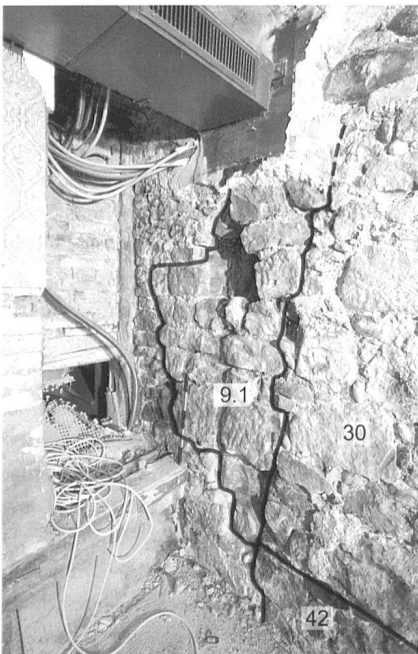
27: Kernbau II, EG, Türe 9.1 von SW.
