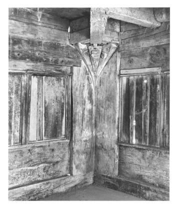
8: Köniz-Grossgschneit 2010. Westecke im Festsaal. In der Mitte ein aufwändiges «Konsolenbündel», welches dem «Bugfächer» auf der Aussenseite entspricht. Mit originalen Läden geschlossene Öffnungen.
