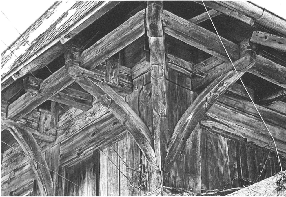
4: Köniz-Grossgschneit 2010. Vordachkonstruktion in der Südecke. Fächerartig angeordnete, geschweifte Büge mit blinden Tartschen.
