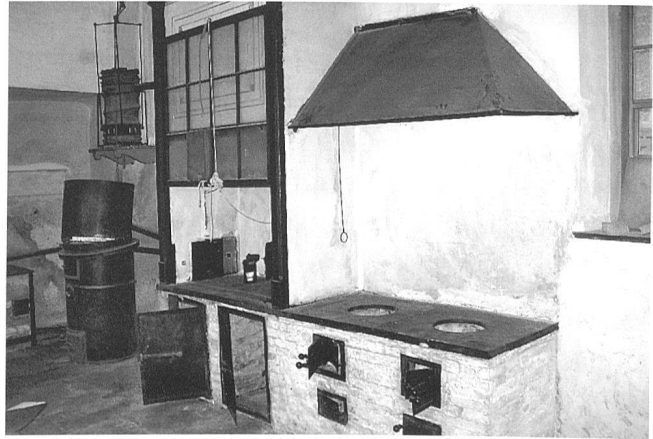
9: Schloss Reichenau. Abzug mit Unterschränken und Herd mit zwei Feuerstellen. Höhe der Arbeitsflächen 77 cm.
