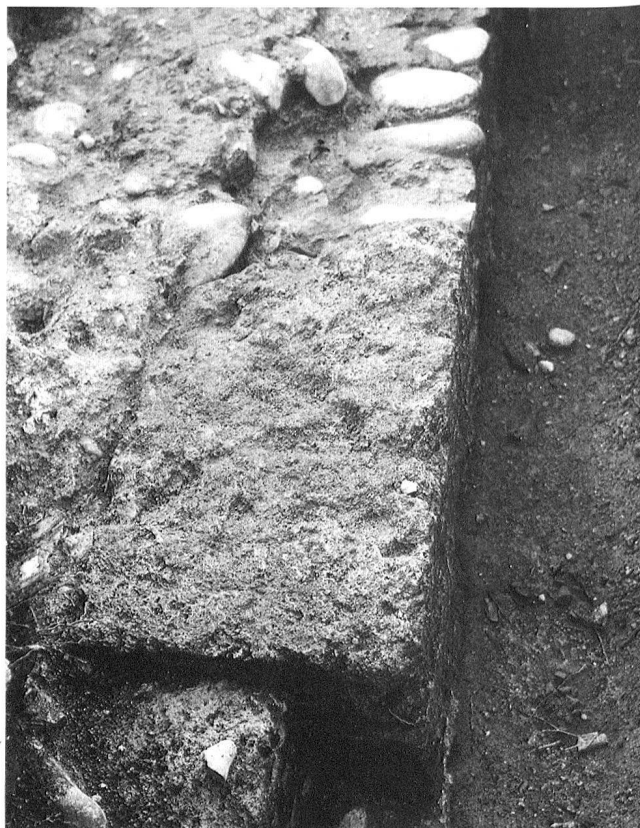
22: Zürich-Lindenhof 1937/38. Jüngeres Pfalzgebäude. Mit Tuffsteinquadern gebildeter Absatz in der Westfassade. Der Stelle entspricht im Innern die Position des nördlichen Wandpfeilers.
