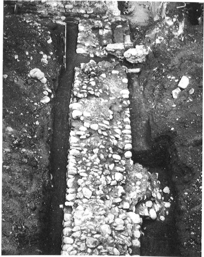
17: Zürich-Lindenhof 1966/67. Jüngeres Pfalzgebäude, Fortsetzung der Westfassade südlich der Kastellmauer. Nach Osten abgehende Binnenmauer mit Setzungsrisen. Blick von Süden.
