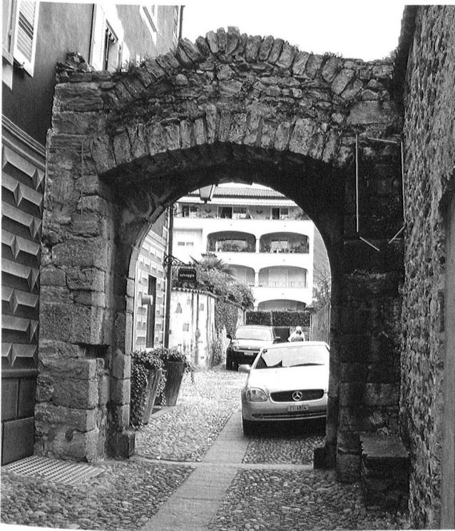
Abb. 27: Ascona, Cast. dei Griglioni. Nordtor, Ansicht von innen (Süden). Der Tordurchgang ist mit einem Flachbogen gedeckt, darüber spannt sich ein Entlastungsbogen. In den markierten Feldern seitlich ist zu bemerken, dass die aussen sichtbaren Rutenkanäle innen nicht erkennbar sind.
