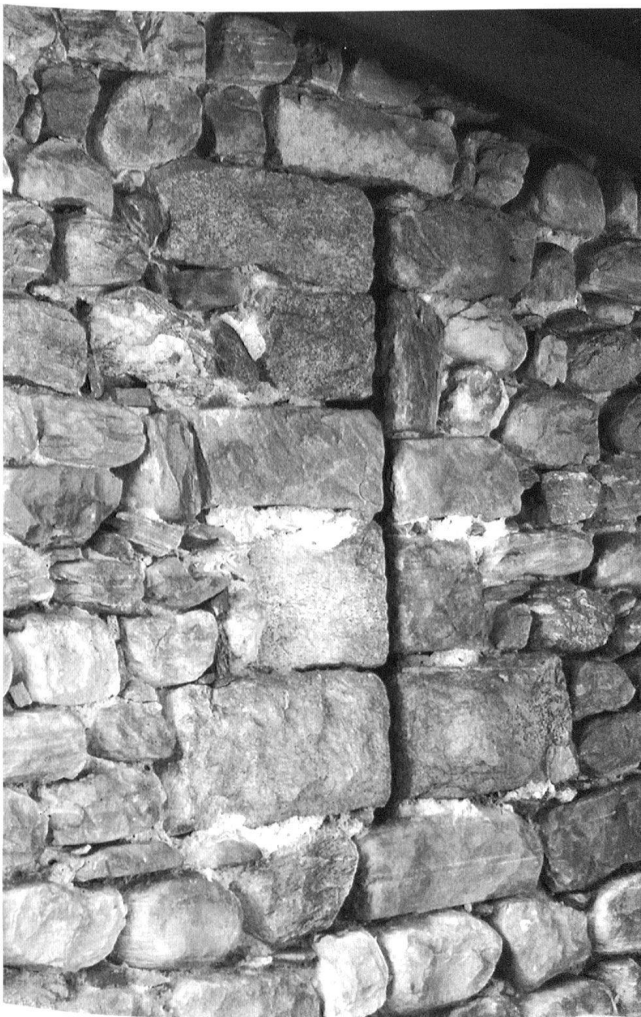
Abb. 14: Ascona, Cast. dei Griglioni. Lichtschlitz im Nordostturm (B).
