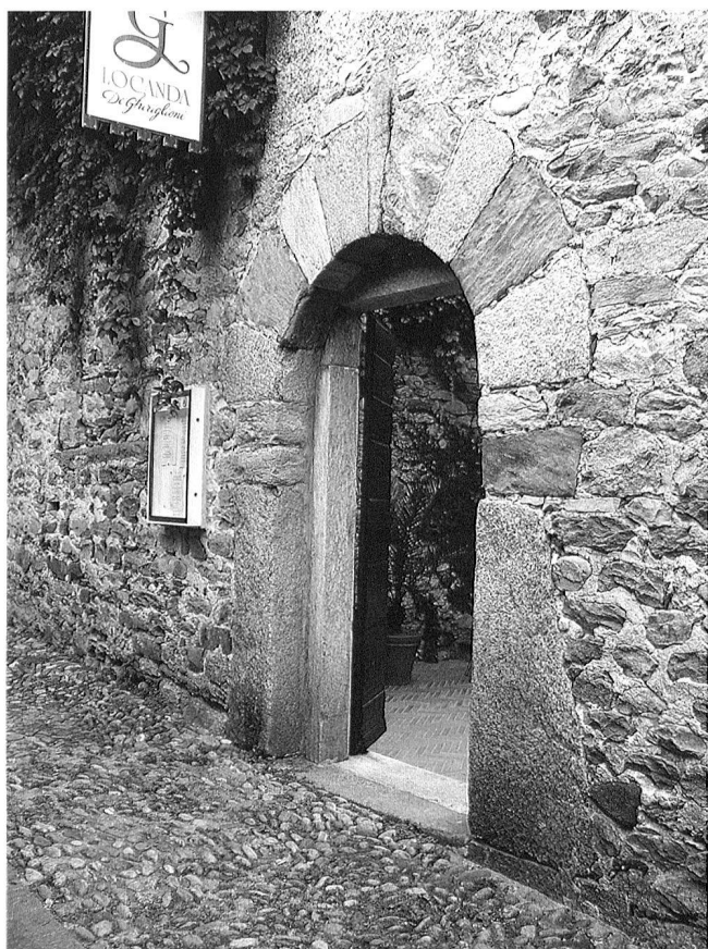
Abb. 25: Ascona, Cast. dei Grigioni. Rundbogentor in der Mauer, die den Vicolo Ghiriglioni (J) im Osten begrenzt.
