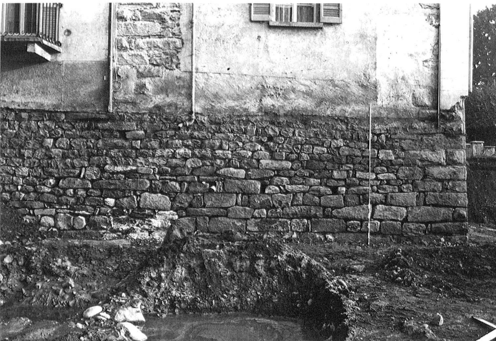
Abb. 22: Ascona, Cast. dei Griglioni. Südwestturm (B). Freigelegtes Fundament von Turm und Kurtine (1967).
