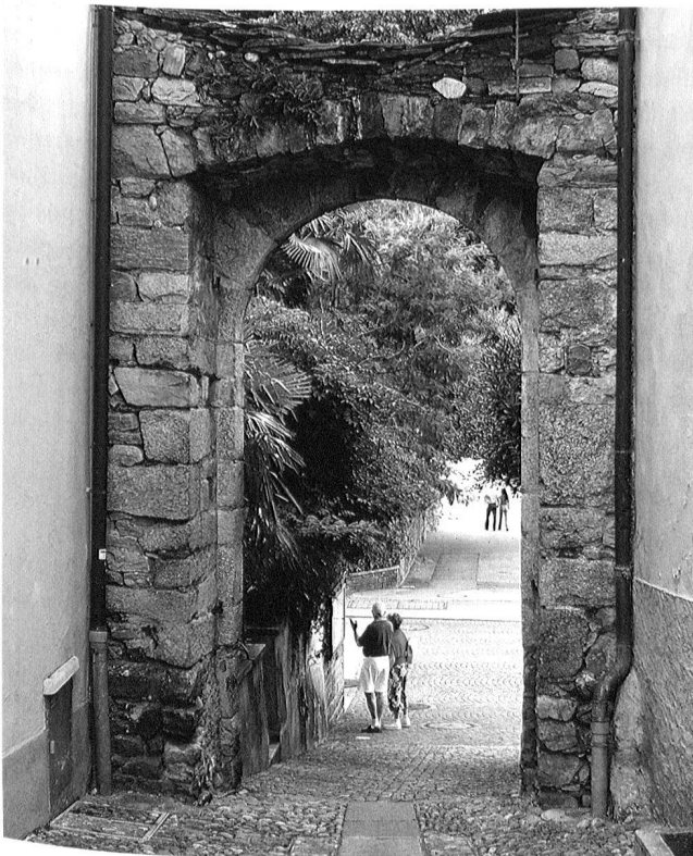
Abb. 28: Ascona, Cast. dei Griglioni. Südtor, Ansicht von innen (Norden). Das Gelände zum See hin fällt deutlich ab.
