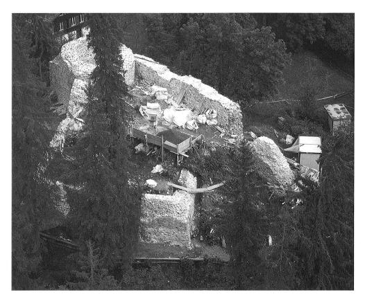
Abb. 9: Unterer Mannenberg. Die Burganlage während der Sanierung. Im Vordergrund der Sockel des Wohngebäudes und links davon der Steilhang zwischen oberem und unterem (weitgehend verschwundenem) Burghof, der von der steil abfallenden Ringmauer abgeschlossen wird. Im Hintergrund der Rundturm; darunter ist ist die Nordecke des mutmasslichen rechteckigen Turmes sichtbar, auf dem der jüngere Rundturm aufsitzt. Luftaufnahme, Blick von Südwesten.
