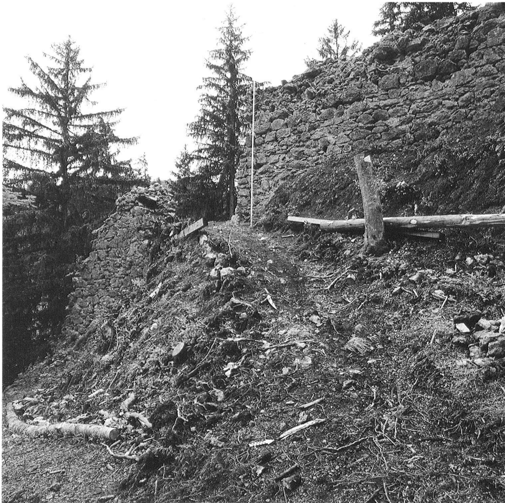
Abb. 7: Unterer Mannenberg. Die Reste des kleinen Portals in der östlichen Ringmauer; südlich davon fällt das Gelände steil ab, wie am Verlauf der Ringmauer gut sichtbar ist. Im Vordergrund die überwachsenen Reste der zum Portal führenden Rampe. Blick von Osten.
