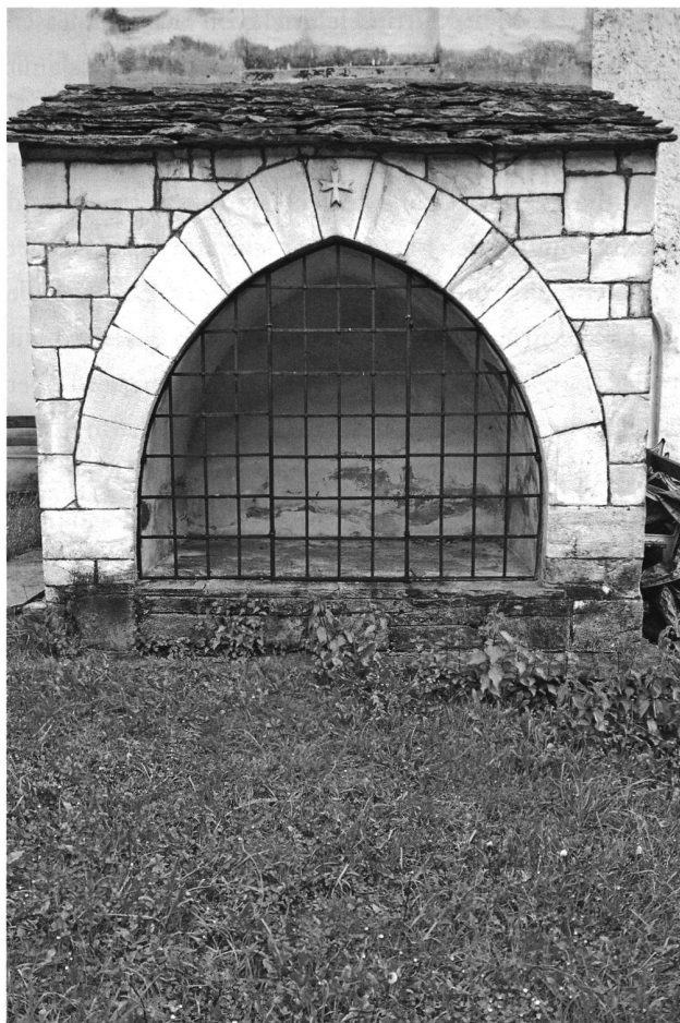
Abb. 2: Mesocco GR, Sta. Maria del Castello. Am Kirchenturm angebaut steht diese Nische mit Spitzbogen. Im Schlussstein befindet sich ein Flachrelief mit Malteserkreuz.
