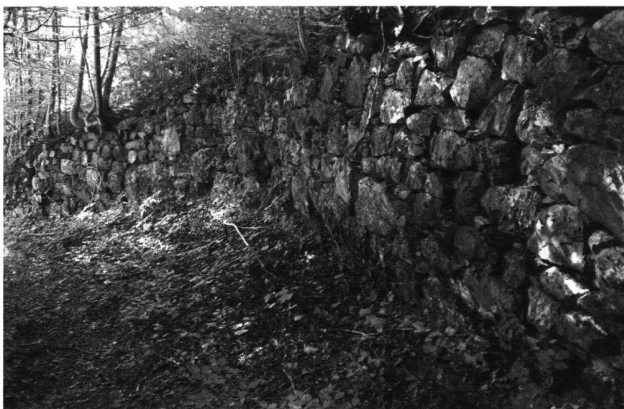
24: Bergseitige Stützmauer von Weg von Schwanden zur Burgstelle Benzigen.
