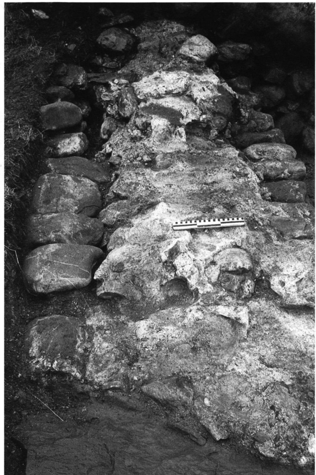
10: Aufsicht auf Mauer M3. Die äussere Mantelmauer (links) hat sich durch Verwitterung und Erosion vom Mauerkern abgelöst, während der innere Mauermantel noch mit dem Mauerkern verbunden ist, ein Zustand, der sich bei allen freigelegten Mauerteilen beobachten liess.
