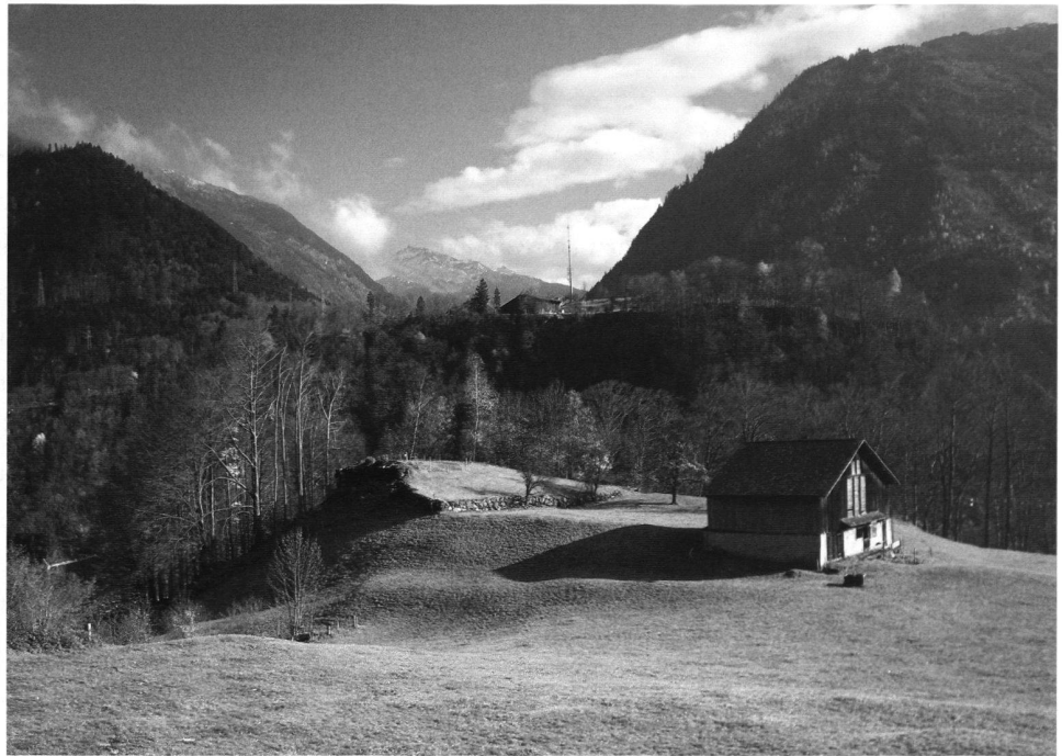
7: Blick von Westen auf die Burgstelle Benzigen. Links die Mauerreste der «Oberburg», rechts die «Unterburg» mit dem Heustall.
