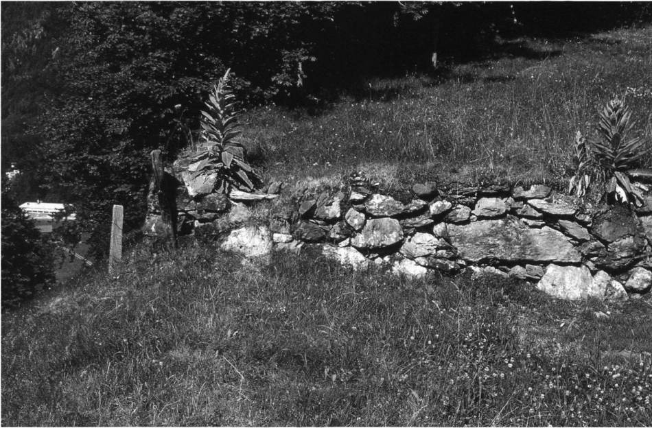
14: Ansicht der Quermauer.
