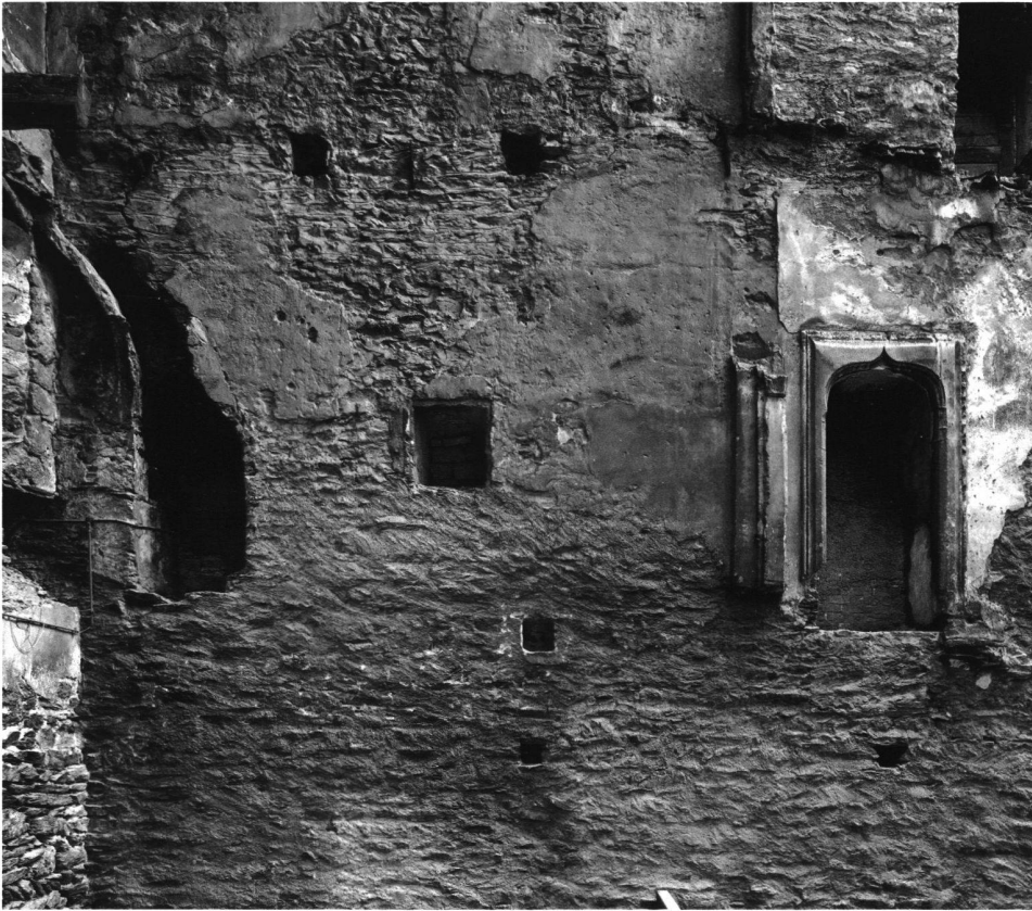
35: Palas-Annex, Südwand. Am rechten Bildrand die Türen, die vom jüngeren Treppenturm aus in den Palas führten. Die Stufen waren seitlich in die Mauer verankert. Am linken Bildrand die Einfeuerungsöffnung eines Stubenofens. Dazwischen eine in die Mauer eingebrochene Durchreiche.
