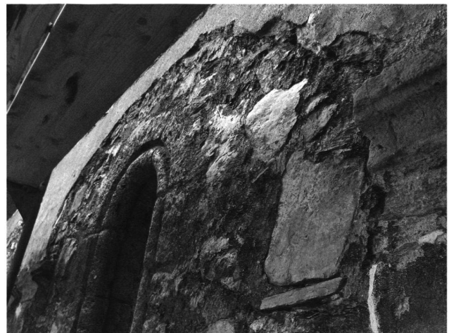
5: Palas-Annex, Nordfassade. Detail der Fenster des ersten Geschosses. Das mit einem Rundstabprofil gerahmte Fenster verdeckt ein älteres, grösseres Fenster, das mit dem Gesims rechts rechnete.
