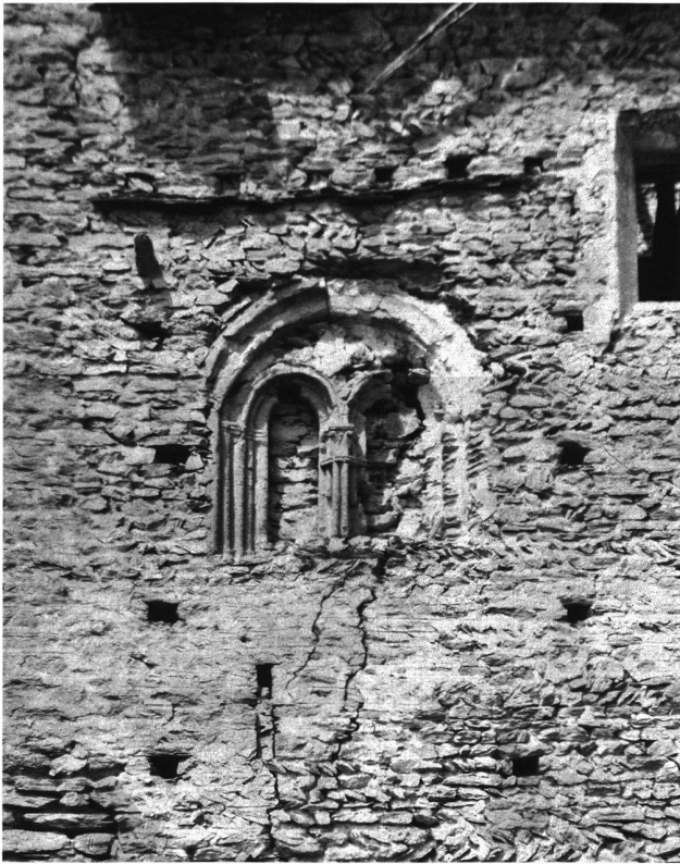
10: Palas-Südfassade. Detail der romanischen Bifore. Über dem Fenster sind die vorkragenden Steinplatten des ehemaligen Satteldaches zu erkennen. Darüber steht die Sockelmauer des Zinnenkranzes mit den Ausgusslöchern, darunter (links) eine Steinkonsole der Dachrinne. Aufnahme von 1937.
