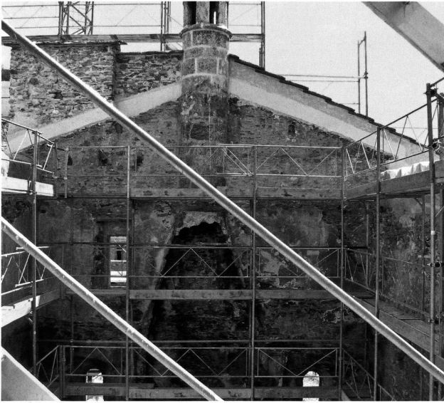
26: Palas-Annex, obere Hälfte der Ostwand. Aufnahme 2006, nach Abbruch der Dachkonstruktion.
