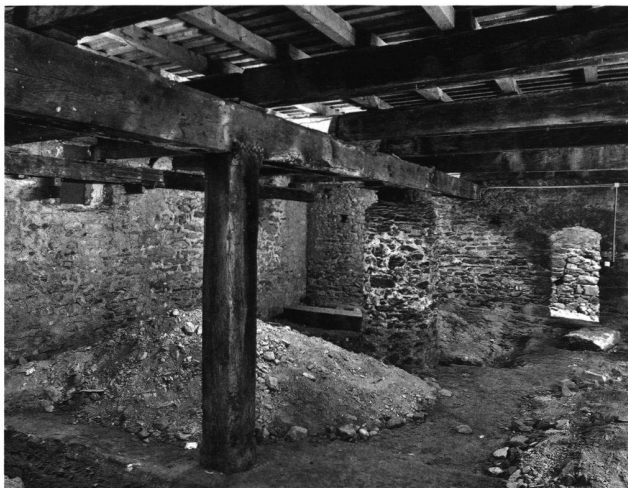
15: Palas, Keller. Aufnahme während der Sondierungsarbeiten von 2001. Hinter der hölzernen Stütze erkennt man die gemauerte Säule und im Hintergrund die Binnenmauer, die den Keller unterteilt. Ansicht gegen Westen.
