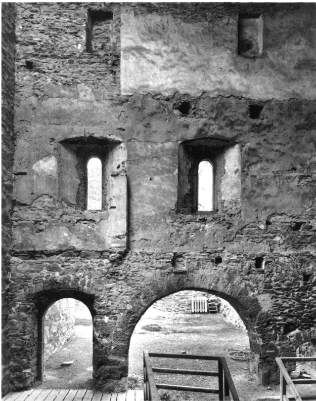
24: Palas-Annex, Nordwand. Balkenlöcher und Verputze lassen eine Gliederung in drei Geschosse erkennen. Zwischen dem Rundbogenportal und der Türe links bestand eine Binnenmauer, die in einer späteren Phase bis ins oberste Geschoss aufgemauert wurde.
