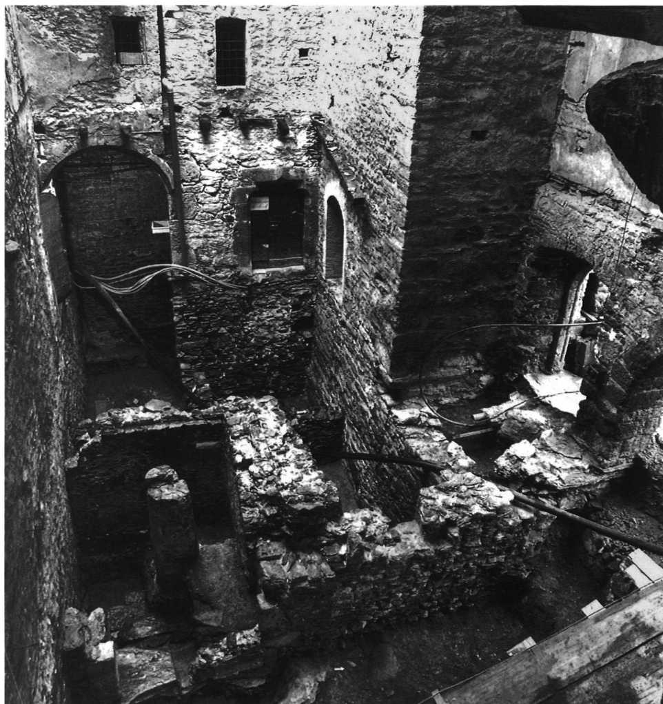
22: Palas-Annex. Übersicht der anlässlich der Ausgrabungen von 1989 entdeckten Mauern. Links unten die gemauerte Spindel einer Wendeltreppe.
