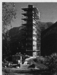
Cagliatscha im Baugerüst am 1. August 1984.
