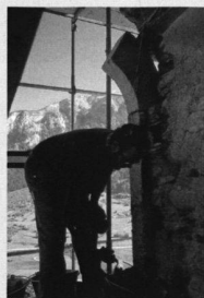
Der im Mauerabbruch kaum mehr erkennbare Hocheingang wird mit zwei zusätzlichen Gewändesteinen aus Reischener Tuff wieder ablesbar gemacht.
