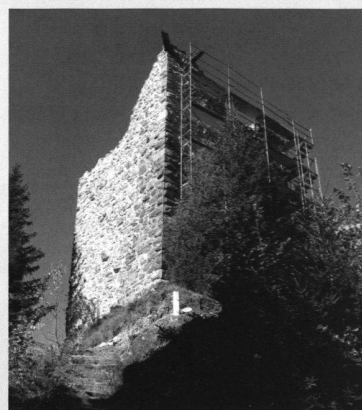
2007: Die Südfront ist gesichert, zwei neue Lärchenstümpfe lokalisieren die verfallenen Kragbalken der Wehrlaube.
