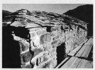
Mauerkrone von Süden nach den Sicherungsarbeiten von 1984. Alle alten Holzteile wurden auf der neu gemauerten Krone in Originallage versetzt. Sie sind wieder mit den alten Steinplatten gedeckt. Um die ganze Mauerkrone schützen zu können, wurde der mittelalterliche Dachrest beidseits mit Platten von einem Stall in Andeer aus dem Vorkommen von Cröt eingedeckt. Links das Loch des Gratsparrens, in der Bildmitte der Austritt auf die obere Wehrlaube, rechts zwei Sparrenreste von 1266.
