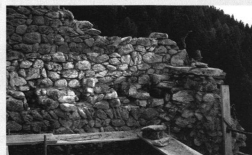
Vorzustand 2004: Balkenlage des dritten Geschosses. Rechts die Torschwelle des Hoheinganges, gut acht Meter über Boden.
