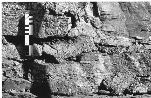
11: Turm, Mauer M2. Bauzeitliche Putzreste mit Abdruck einer Maurerkelle (Kote 759.80).
