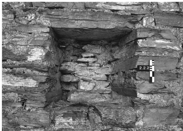
16: Turm, Mauer M2. Innenansicht des nachträglich zugemauerten Fensters 2.2, von NNW.
