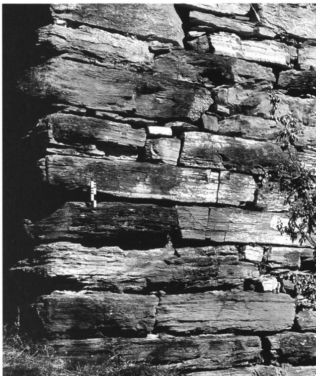
3: Turm, Mauer M2. Senkrecht zur Schichtung geborstene Mauersteine neben der Ecke M2/M3, von S.
