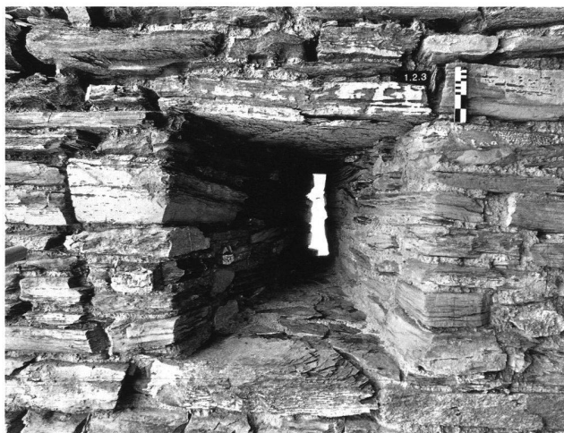
15: Turm, Mauer M1. Fenster 1.3, Innenansicht, von WSW.
