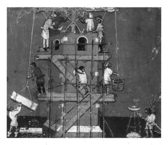
29: Spätmittelalterliche Darstellung einer Baustelle mit einem Kran und einem Stangengerüst mit Laufschräge. Rudolf von Ems, Weltchronik, 1385.
