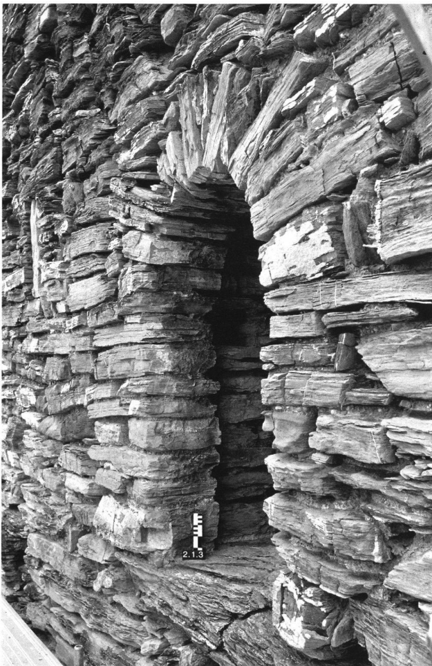
18: Turm, Mauer M2, Hocheingang. In der Leibung hinter dem Türanschlag ist die quadratische Mündung des Sperrbalkenkanals zu erkennen, von OSO.
