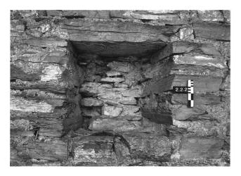
16: Turm, Mauer M2. Innenansicht des nachträglich zugemauerten Fensters 2.2, von NNW.
