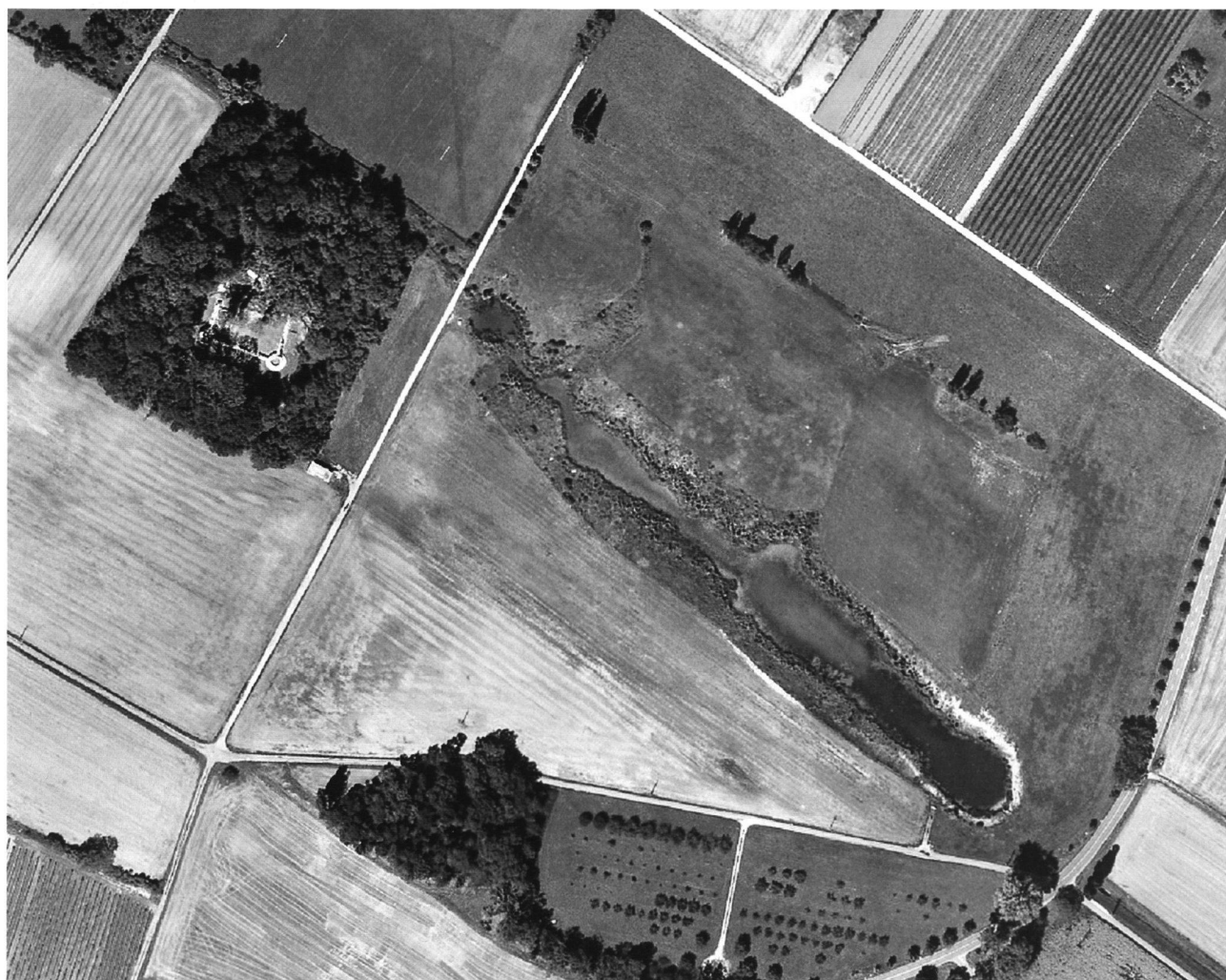
4 : Vue aérienne sur les ruines du château de Rouelbeau et le plan d'eau créé à proximité dans le cadre du projet de revitalisation des sources de la Seymaz. – Luftbild mit der Ruine Rouelbeau (links) und dem länglichen Teich (rechts), der im Rahmen der Revitalisierung der Quellen der Seymaz entstand.
