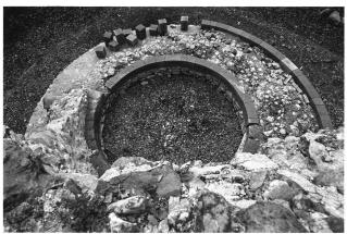
Fig. 22. Vue plongeante sur les vestiges de la tour sud-est en cours de consolidation et de restauration partielle. – Sicht auf die Mauerreste des Südostturmes während der Sicherungsund Restaurierungsarbeiten. Da für die Mantelsteine kein brauchbarer Stein in der Nähe zu finden war, wird ein rötlicher Sandstein aus den Vogesen zum Wiederherstellen der Mantelmauer verwendet.
