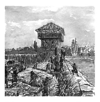
12 : Restitution du chantier de construction de la bâtie en bois édifiée au cours de l'été 1318. - Rekonstruktionsversuch des Bauplatzes im Sommer 1318; der hölzerne Viereckturm (C) ist schon errichtet. Die oben zugespitzten Pfosten der Palissade werden in einen schmalen Graben gesetzt.
