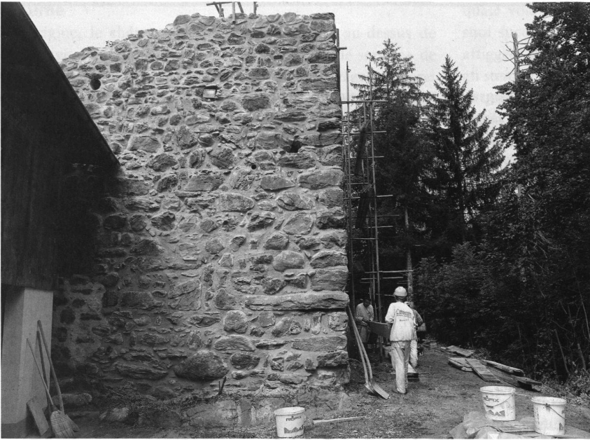
1: Strahlegg. Die gesicherte Nordost-Ecke von Strahlegg (Foto BVG).
