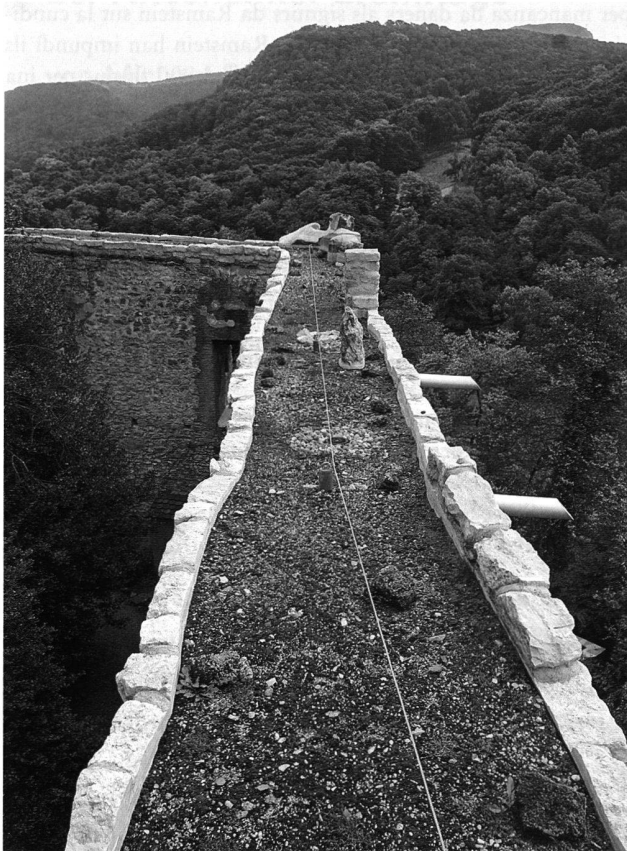
25: Arlesheim-Birseck, sanierte Südfassade: Die wasserdicht abgeschlossene Mauerkrone wurde begriert und bietet so einen speziellen Lebensraum für Flora und Fauna. Wasserspeicher leiten das Regenwasser weit von der Mauer weg; fest installierte Drahtseile erleichtern den späteren Zugang für Unterhaltsarbeiten.
