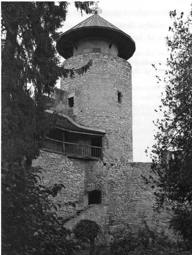
7: Arlesheim-Birseck, hofseitige Ansicht des hochmittelalterlichen Wehrturms. Über dem Dach des jüngeren Wehrganges ist der auf Fenstergrösse zugemauerte ursprüngliche Hoch- eingang zu erkennen.
