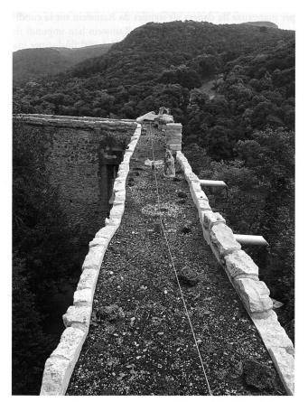
25: Arlesheim-Birseck, sanierte Südfassade: Die wasserdicht abgeschlossene Mauerkrone wurde begrient und bietet so einen speziellen Lebensraum für Flora und Fauna. Wasserspeier leiten das Regenwasser weit von der Mauer weg; fest installierte Drahtseile erleichtern den späteren Zugang für Unterhaltsarbeiten.
