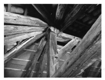
10: Stuhlständer der Walmkonstruktion im westlichen Dachwerk des Nordtrakts.
