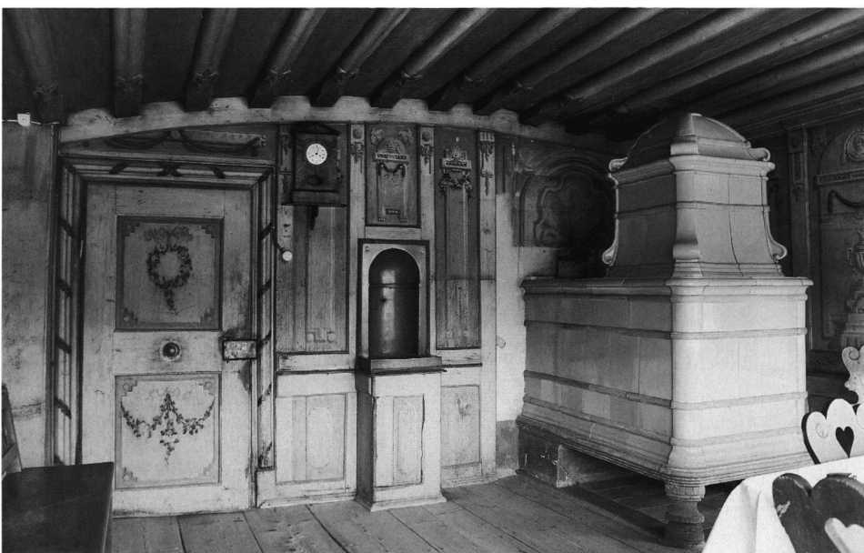
12: Stube des Torturms mit Bohlenbalkendecke, um 1485/86, Malerei Joseph Anton Puellacher zugeschrieben, um 1786/87.
