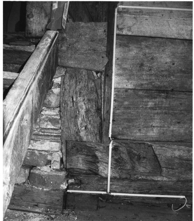
11: Nordwestlicher Eckständer des Torturms mit übers Eck geführtem Ständerfussblatt (gegen Westen nachträglich abgearbeitet).
