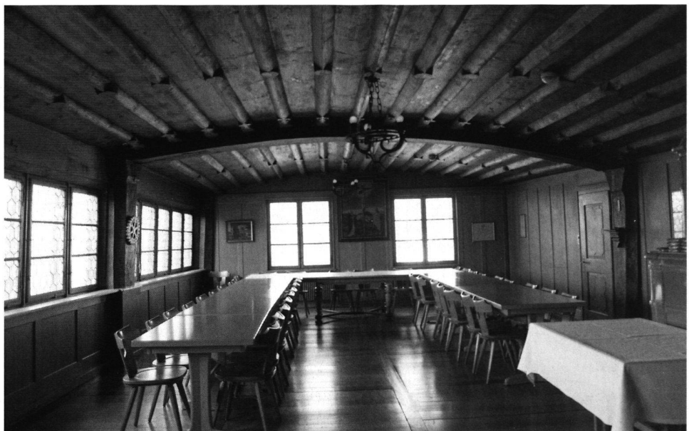
9: Saal mit Bohlenbalkendecke, um 1415–1425.
