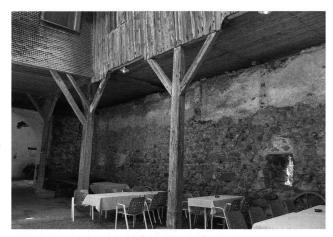
13: Innenseite der südlichen Ringmauer mit Putzresten einer abgegangenen Wehrgangkonstruktion.
