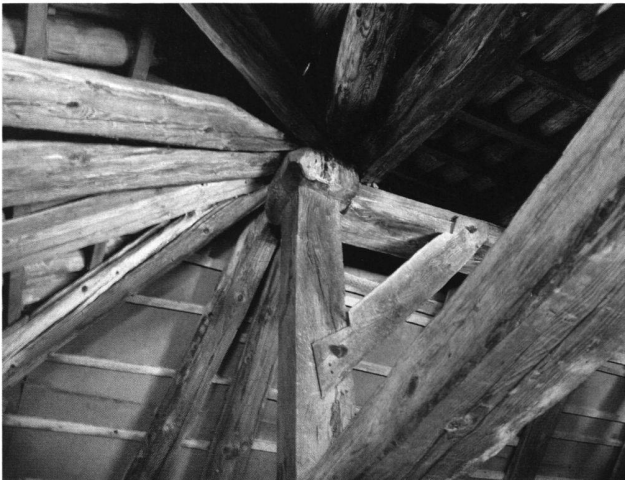
10: Stuhlstander der Walmkonstruktion im westlichen Dachwerk des Nordtrakts.
