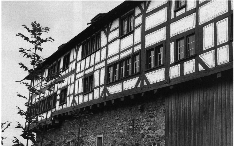
8: Detail von Nordfassade des Nordtrakts.
