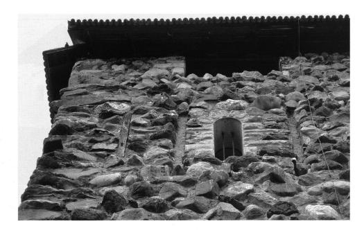
6: Turm, 1. Obergeschoss, nördliche Rundbogenöffnung mit seitlichen Balkennegativen und drei Balkenlöchern (unten).
