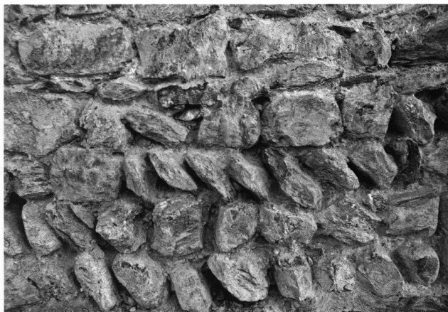
13: Palas Südfassade, Mauerwerk 1.
