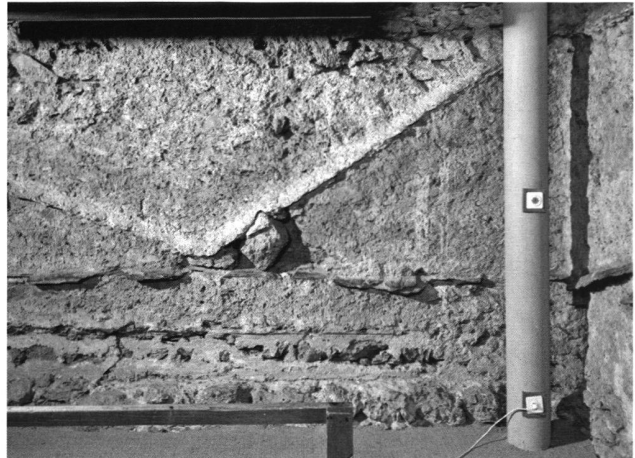
11: Bergfried 5. OG Ostmauer. Von unten nach oben: Negativ der Satteldach-Traufpfette. An seinem oberen Rand Abdrücke der Schindeldeckung, 25–30 cm weiter oben horizontaler Wasserschlag aus Melserplatten. Auch am hellen Mörtelkragen des Taschendaches zeichnen sich Schindel- negative ab.
