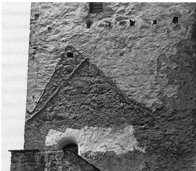
18: Bergfried Ostseite. Teilweise freiliegendes Tuffquadermauerwerk und Dachanschlüsse des «Hinteren Schlosses». Darüber weisser Verputz des 17. Jahrhunderts. Aufnahme 1964.
