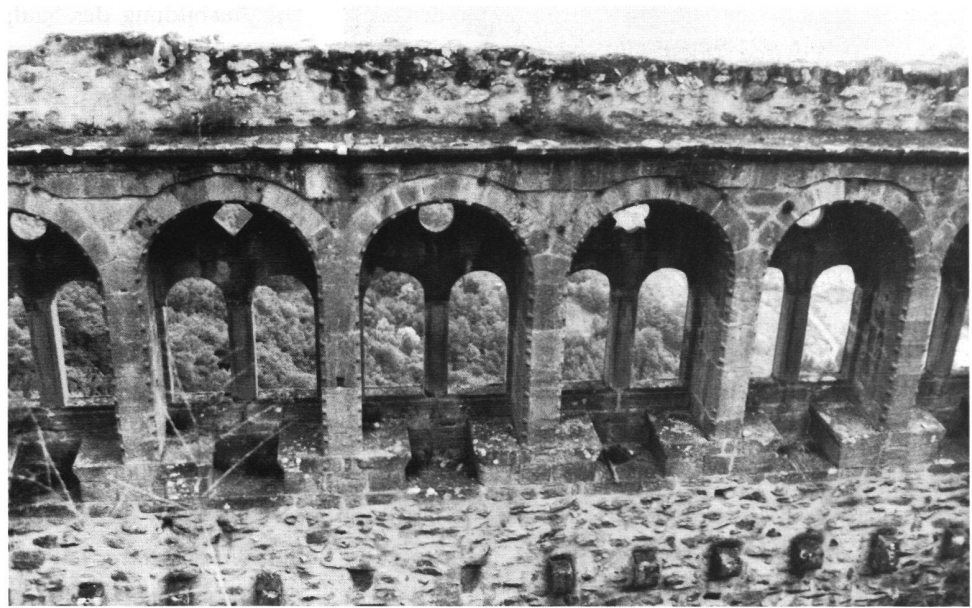
12a, b: Ulrichsburg/Elsass. Innenansicht Saalbau erstes Obergeschoss, Fenster mit Sitzbänken, heutiger Bestand. Saalfenster mit Ver- riegelung um 1900, Zeich- nung von Bodo Ebhardt.
