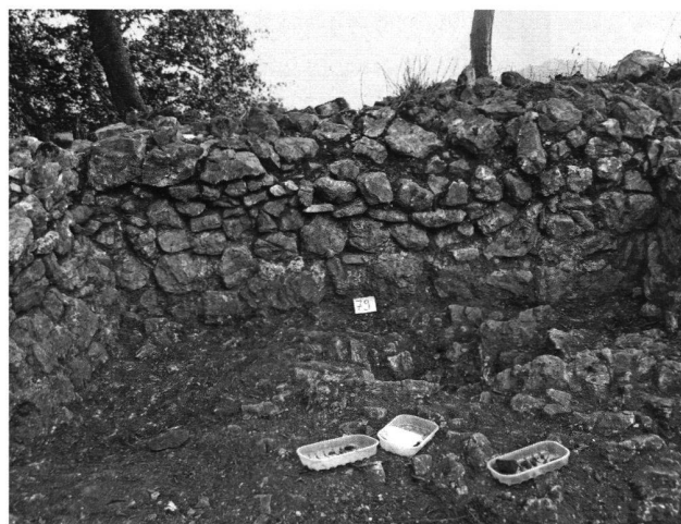
11: Beispiel eines gewöhnlichen Mauerabschnittes.
