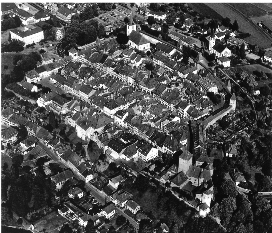
6: Die Stadt Murten. Blick nach Südosten. Im Vordergrund die savoyische Stadtburg, diagonal dahinter die französische Kirche.
