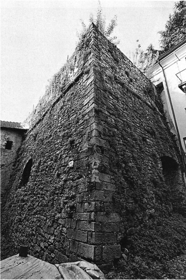
3: Keil des «Rivellino» mit den geneigten Escarpeflächen. Die senkrechte Brustmauer (oben) ist durch einen Kordon (Schnurprofil) abgesetzt.
