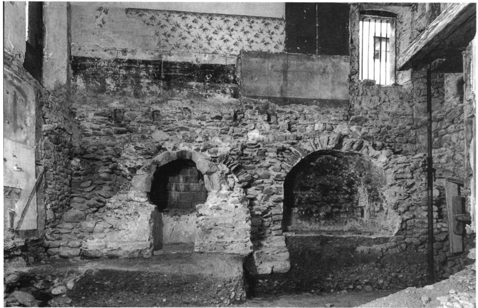
12: Rue des Deux-Marchés n° 34, murs 5 (pont) et 7 (four). – Mauer 5 (Brücke) mit zwei Brückenbögen. In den westlichen (linken) wurde nachträglich der Backofen 7 eingebaut.
