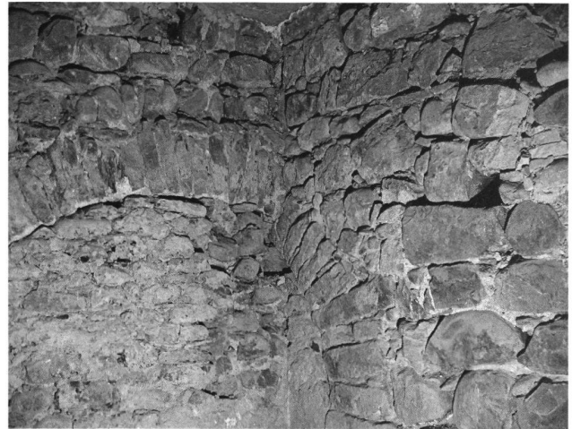
8: Rue des Deux-Marchés n° 34, rez-de-chaussée, local sud-est, jonction des murs 14 et 22. – Erdgeschoss, Raum Südost. Anschlüsse der Mauern 14 (links) und 22 (rechts).
