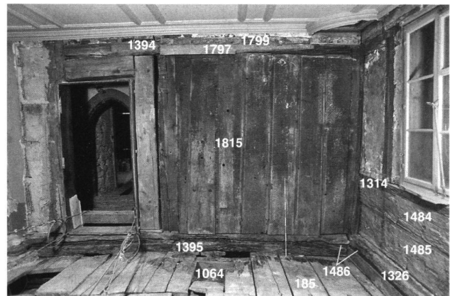
15: Südwand der westlichen Hauptkammer während der Umbauarbeiten 1978, Ansicht nach Süden. Vor allem rechts sind Reste der jüngeren Bemalung auf dem Täfer (1815) von 1355 sichtbar. Das Täfer ist heute in einem «bauhistorischen Fenster» einsehbar. Für die Nummern vgl. Abb. 7 und 13.
