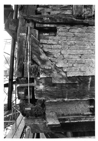
14: Der untere Abschluss der Nordwestecke 1979, Ansicht nach Osten. Auf den zwei Tragbalken (1068) und (1069) liegen die Reste der Bodenbretter (185) und darauf die nördliche und die westliche Fassadenschwelle (1196) und (1326). Das Fussholz (1318) verbindet die Schwelle mit dem Eckständer (1295), über den der Brüstungsriegel (1314) mit der Wassernut (1315) greift. Hinter der Backsteinvormauerung aus der Zeit nach 1763 stecken die Wandbohlen (1484).
