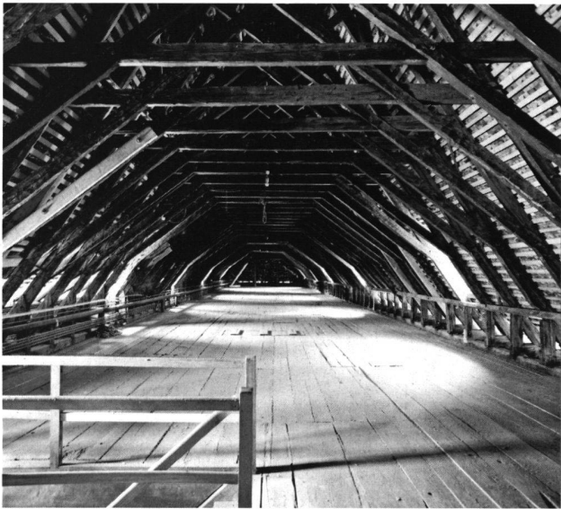
7: Basel, Unterer Rheinweg 26. Dachwerk von 1274(d) über dem «Dormitorium» des Klosters Klingental.
