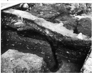
14: Altenberg. Bodensetzungen führten zum Abreissen des Aussenmantels auf einem längeren Abschnitt der Ringmauer.
