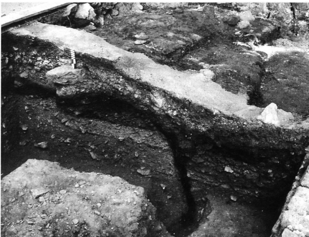
13: Altenberg BL. Der Setzungsriß in der Aufschüttung im Hauptbau wurden vom Gewicht der Aussenmauern verursacht.
