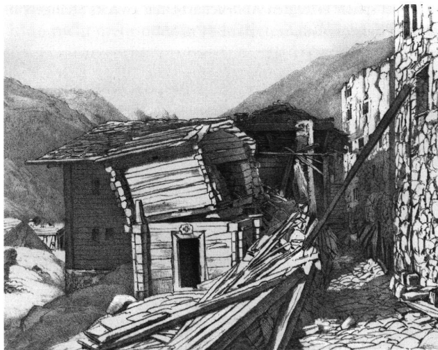
1: Visp VS, Erdbeben von 1855. An den Stein- und Holzbauten entstanden unterschiedlich starke Schäden.
