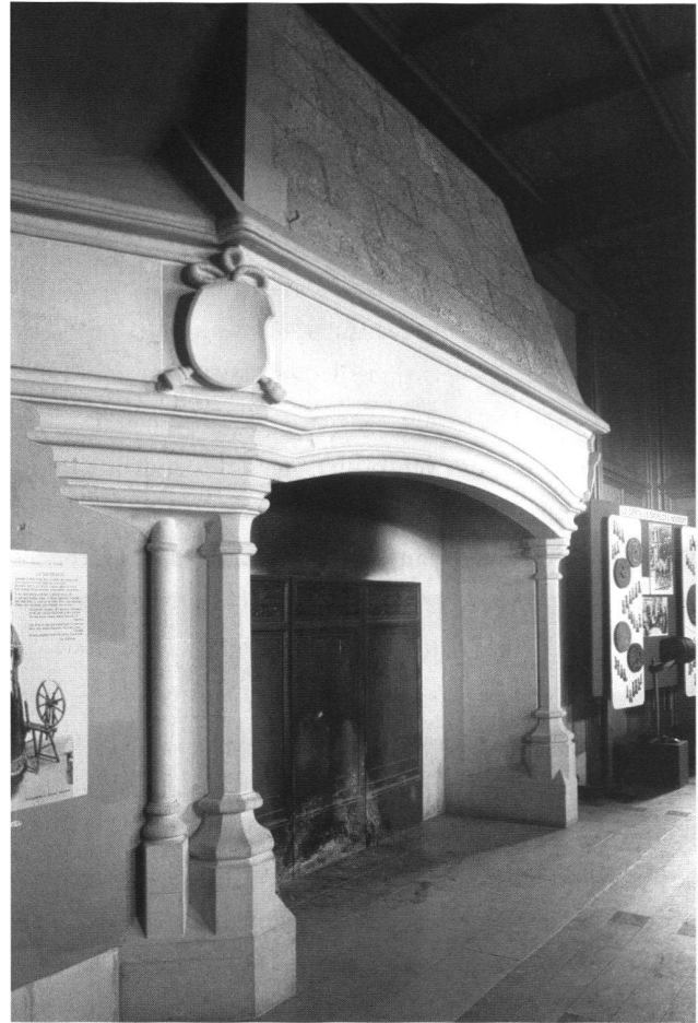
7: Cheminée d'Amédée VIII, reconstruite en matériaux modernes.
