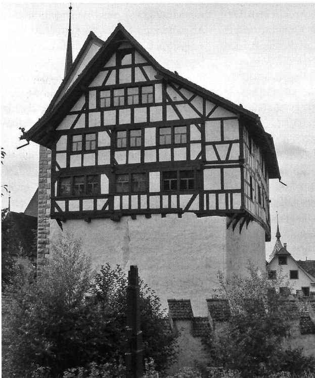
Burg Zug Ostfassade.
