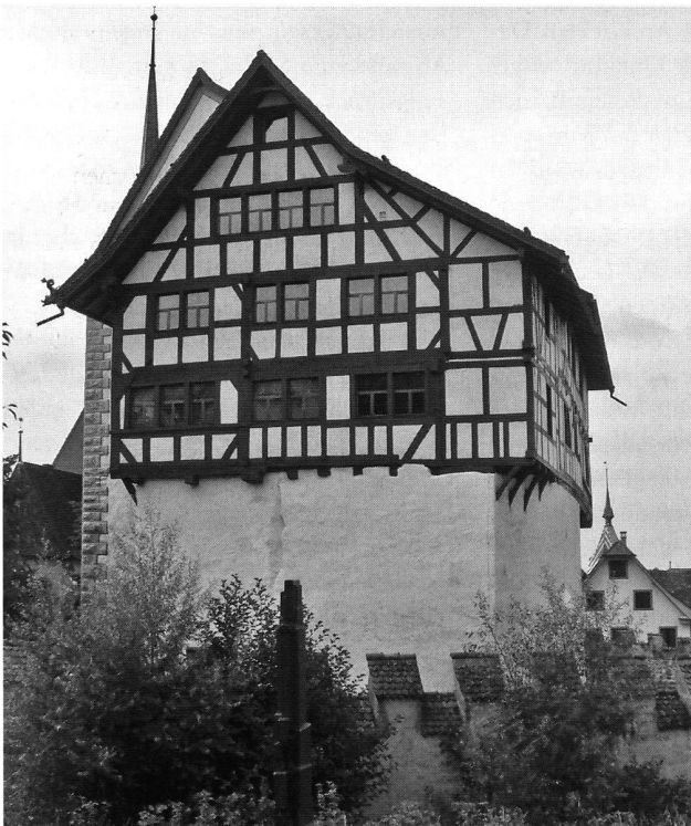
Burg Zug Ostfassade.
