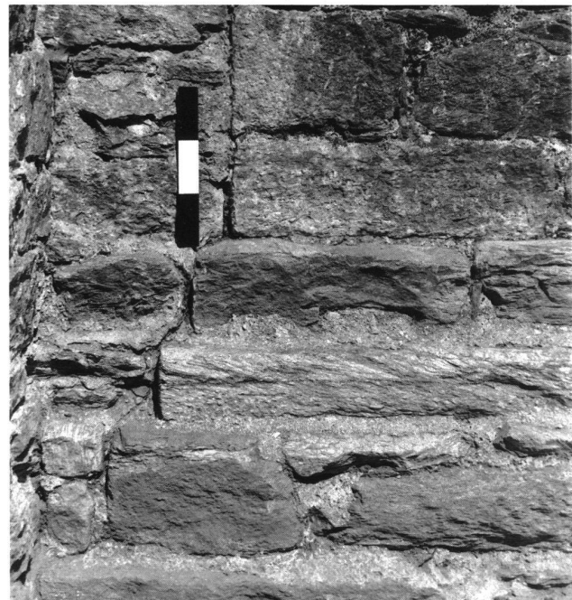
9: Serravalle. Nordwestecke des Hauptbaues E/F/G. Eckverband mit abgetrepptem Fundament. Links mit Stossfuge die Mauer des Latrinenbaues L (2004).
