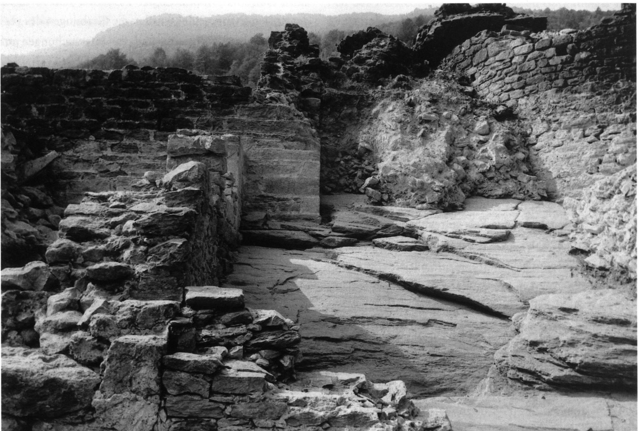
6: Serravalle. 2004 freigelegte äussere Toranlage zwischen Raum X und Y. Im Hintergrund die Nordecke des Baues E/F/G und der Stumpf des Rundturmes T, dazwischen Mauerschutt und abgestürzte Mauerblöcke.
