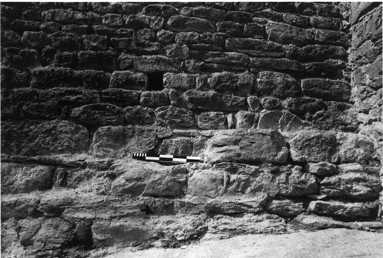
18: Serravalle. Östliche Ringmauer aus Periode 2, Phase 1. Unterhalb des Massstabes Fundamentreste aus Periode 1 (2003).
