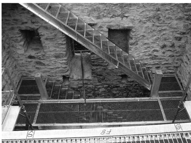
17: Ruine Resti. Die neue Innentreppe zur Aussichtsplattform. Foto während Einbaus im Spätherbst 2004.
