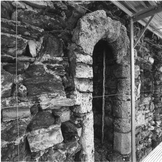
12: Ruine Resti. Rundbogiger Austritt auf den hölzernen Wehrrerker der Südfassade. Links neben dem Portal wandbündig abgewitterte Bohlen der westlichen Erkerwand, rechts Lichternische und anschliessend die Lücke der völlig ausgewitterten Hölzer der Ostwand.
