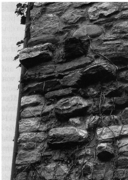
16: Ansicht der nordwestlichen Ecke der Kirche von Westen. Aus der Mauerflucht ragen Steine vor, die einen ehemaligen Maueranschluss der Umfassungsmauer (7) bis unters Dach andeuten.
