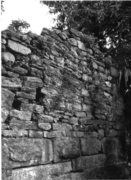
13: Ansicht der südöstlichen Turmecke von Westen.
