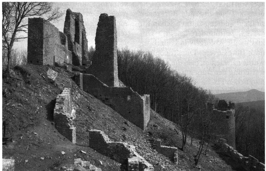
21: Die Burgruine nach der Sanierung 2003, von Westen.
