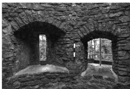
13: «Pulverturm» (L) 2003, 1935 rekonstruiertes Schartenfester (links) und Schlüsselscharte ohne Leibung (rechts) im 1. Obergeschoss, von Norden.
