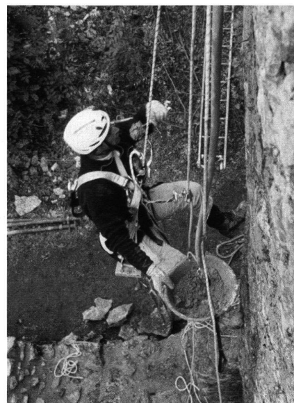
6: Ausfugen des Mauerwerks mit der Kletterausrüstung während der Sanierung 2003.
