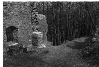
14: Zugangsbereich (K) 2004, Burgtor an Mauer M23 mit Bogenstücken, von Südwesten.
