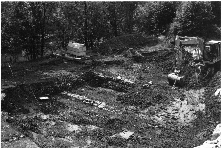
11: Blick in die Baugrube während der Baggerarbeiten und auf die frisch freigelegten Abbruchkronen der Mauern M1 (im Hintergrund) und M2, von NW.
