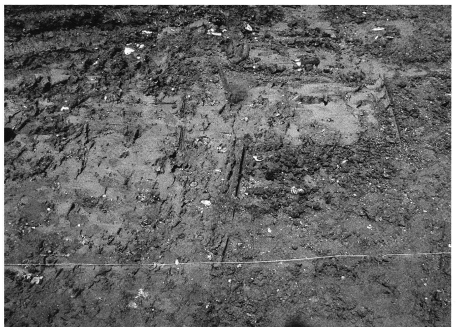
5: Kleine präparierte Fläche mit gut sichtbaren, beim Glätten der Baugrubensohle gekappten Pfählen.
