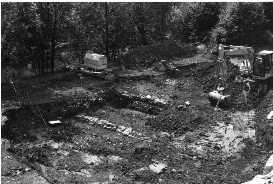
11: Blick in die Baugrube während der Baggerarbeiten und auf die frisch freigelegten Abbruchkronen der Mauern M1 (im Hintergrund) und M2, von NW.
