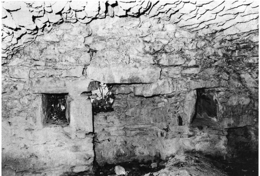
4: Ansicht der Ostwand im Keller.
