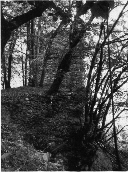
12: Ansicht des Turmbaus mit der westlichen Geländestützmauer.
