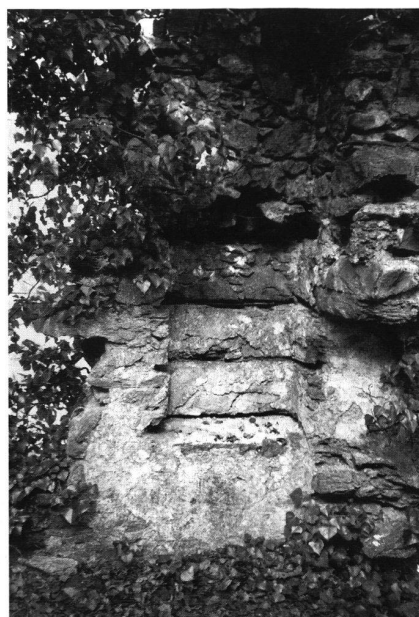
9: Wandnische mit 4 Tablarnuten in der Ostwand des Obergeschosses.
