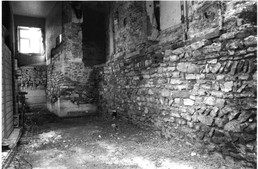
5: Die freigelegten Fundamente der Burkhard'schen Stadtmauer und des zugehörigen Eckturms im Lobnbhof hinter der Leonhardskirche.
