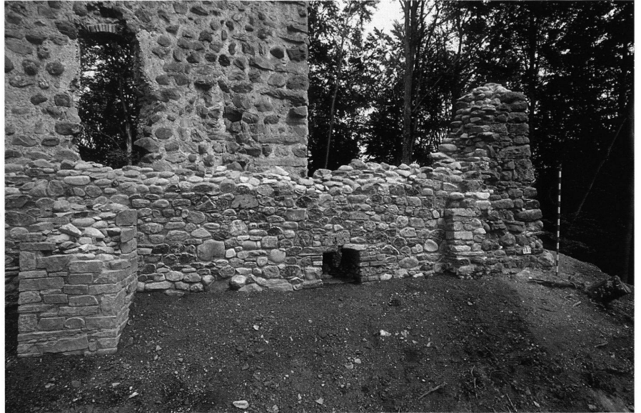
15: Äusserer Mauerring M10, Südteil, nach der Restaurierung.
