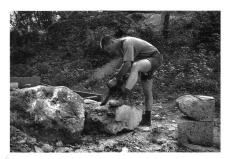
11: Zersägen von Tuffstein mit der Motorsäge.
