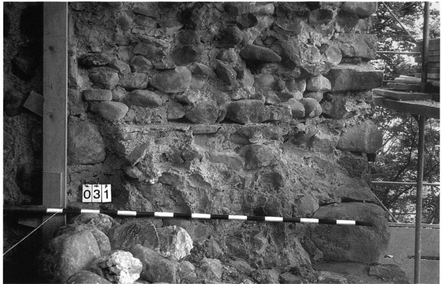
22: Mörtelfuge im Bergfried. Westwand.
