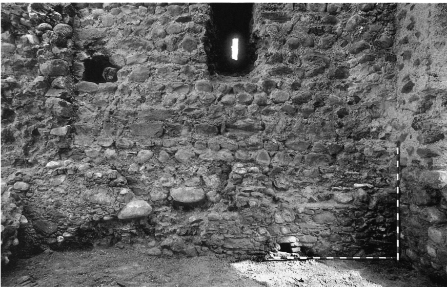
26: Bergfried, Ostwand, Innenseite mit Gewölbeansatz und Schartenfenster.
