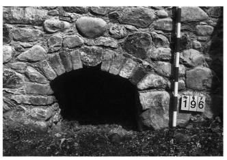
13: Wasserdurchlass in Mauer M10 nach Restaurierung.
