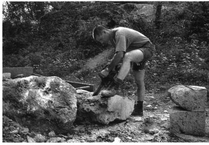
11: Zersägen von Tuffstein mit der Motorsäge.
