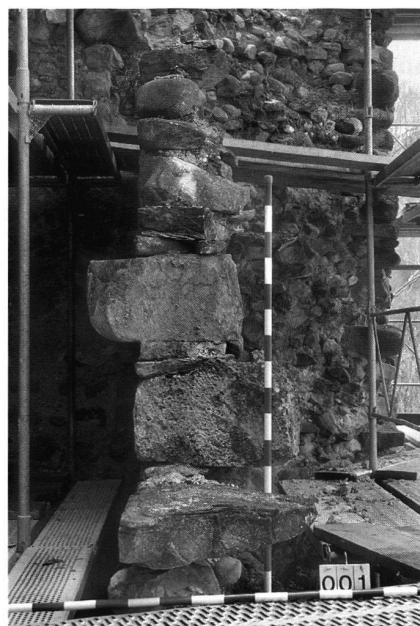
23: Südliches, inneres Türgewände des Hocheingangs.
