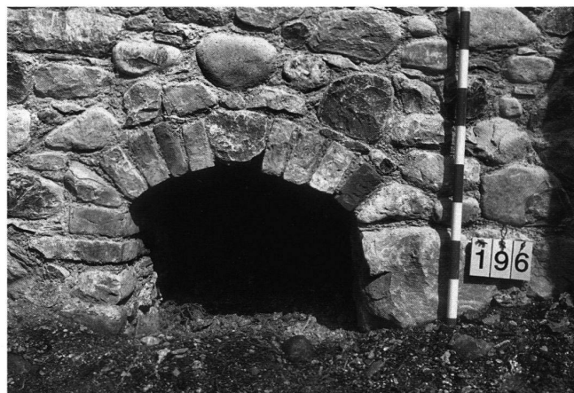
13: Wasserdurchlass in Mauer M10 nach Restaurierung.
