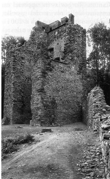
39: Bergfried nach der Restaurierung.
