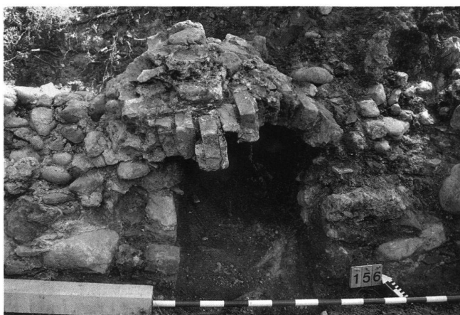
12: Wasserdurchlass in Mauer M10 vor Restaurierung.
