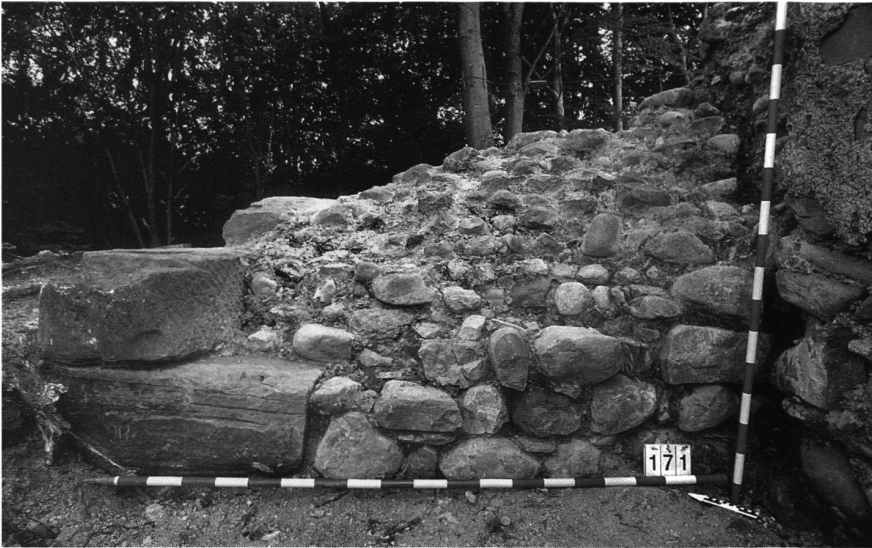
25: Nordwestecke des Palas mit Sandsteineckquadern.
