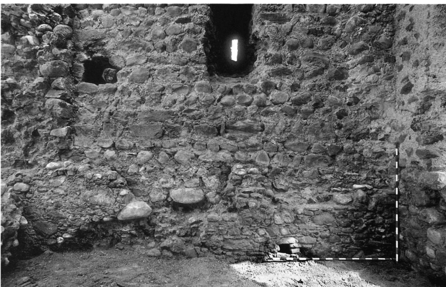
26: Bergfried, Ostwand, Innenseite mit Gewölbeansatz und Schartenfenster.
