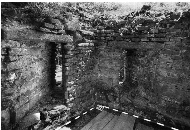
29: Schiessscharten in der Südwestecke der Zinnen.
