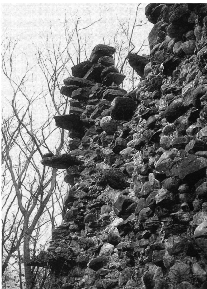
6: Eine Geröllhalde – Innenseite der Ostwand des Bergfrieds, April 2001.
