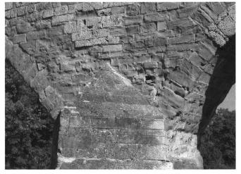
Buntes Mauerbild: Südseite zwischen Bogen 4 und 5. Strömungsabweiser aus grauem Sandstein; Originalsubstanz aus stark abgewittertem Appenzeller Sandstein; ältere Reparaturen aus Rorschacher Sandstein und Tuff. Aufn. AATG.
