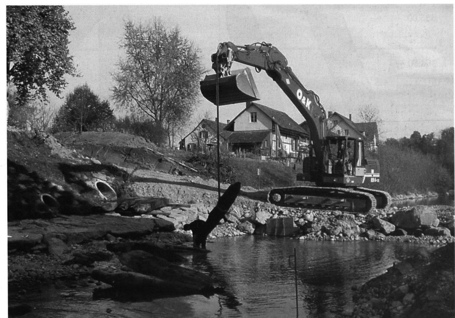
11: Die teilweise bis zu 3 m in den Flussgrund getriebenen Pfähle mussten mit dem Bagger aus dem Boden gezogen werden.
