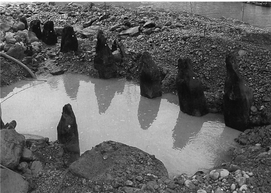
6: Trockengelegtes Flussbett zwischen den Jochen 5, 6 und 7.
