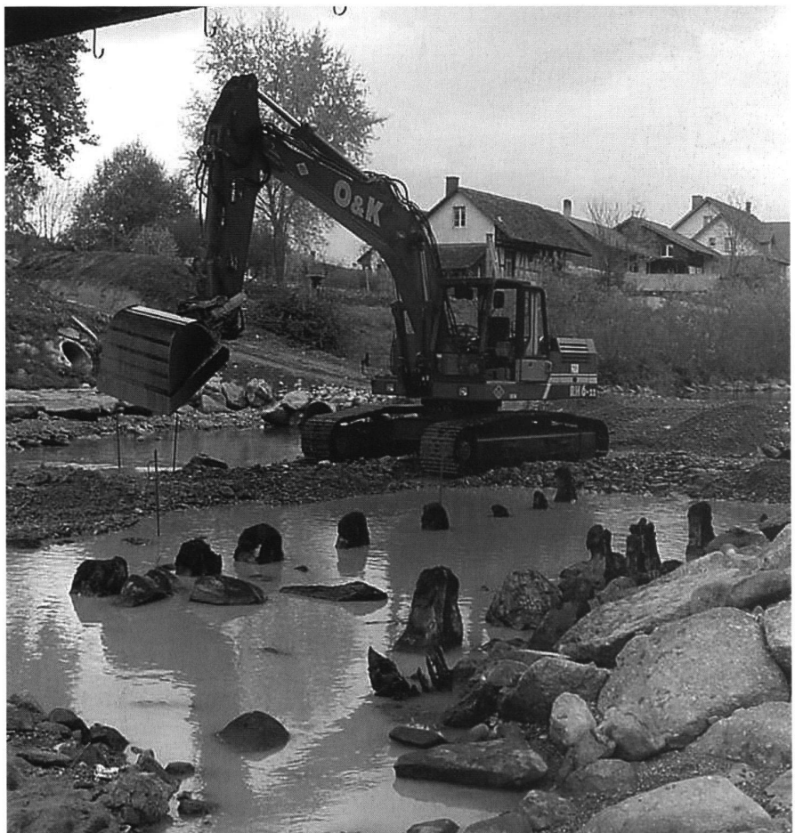
5: Unterhalb des Hauptwalls im Bereich der Joche 5, 6 und 7 abgetrennte, aber noch nicht ausgepumpte Wanne.
