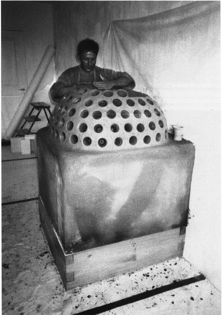
1: Der Hafner F. Mathys beim Aufbau der Kuppel.
