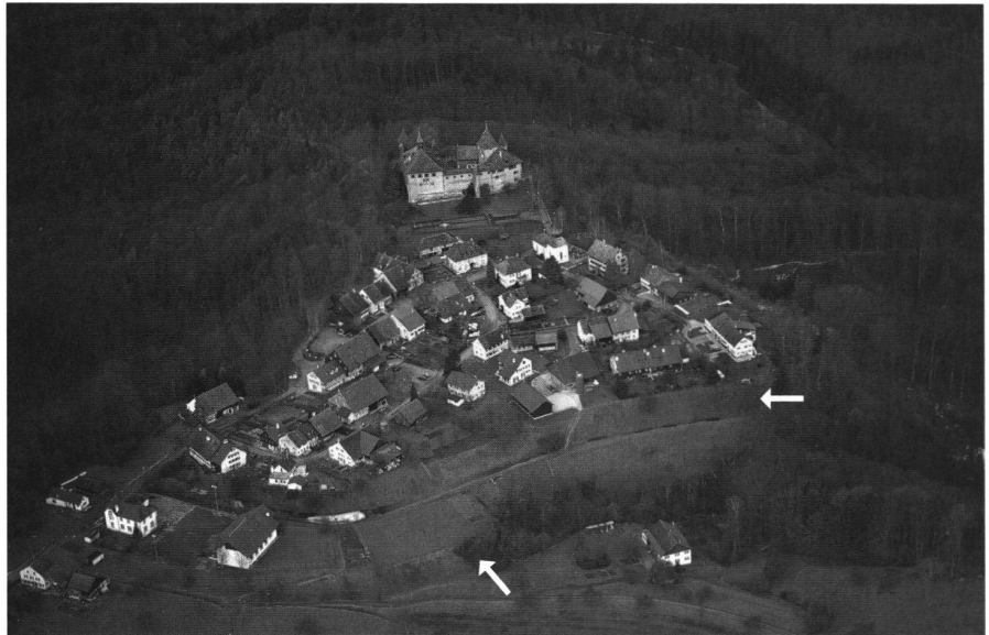
1: Burg und Vorburg Kyburg liegen auf einem Sporn, der ins tief eingeschnittene, bewaldete Tösstal abfällt. Die Pfeile markieren den Doppelgraben, welcher die Vorburg gegen das ansteigende Gelände schützte.
