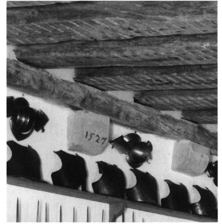
36: «Ritterhaus», Südtrakt, zweites Geschoss. Zahlreiche in der Binnenmauer sitzende Konsolsteine tragen die Jahreszahl 1527. Die Streif- und die Deckenbalken wurden 1371 geschlagen.
