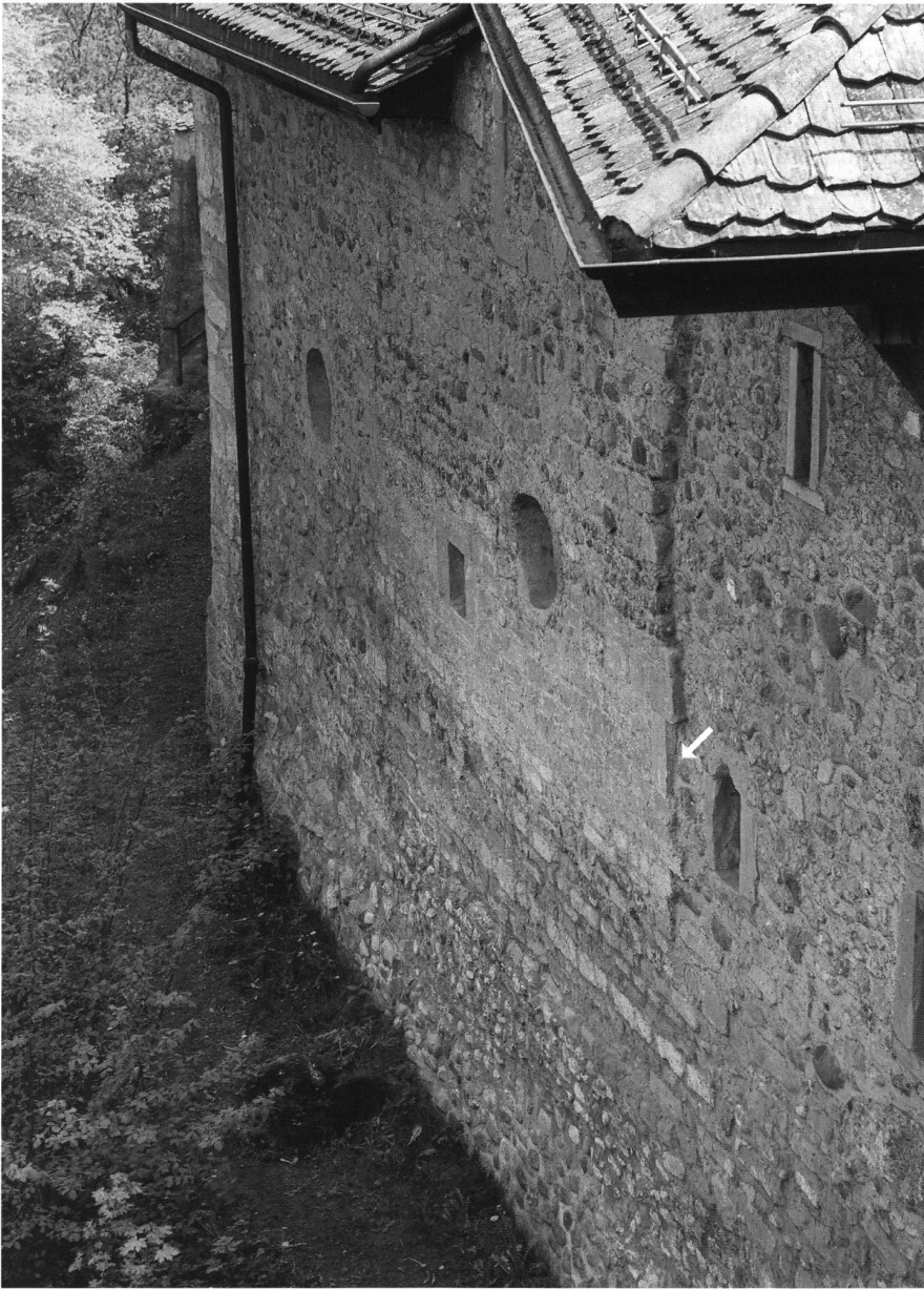
46: In der Bildmitte befindet sich das Quaderwerk des Kernbaus Nord, das sich vor allem auf den Bereich der Viereckfenster konzentriert. Von diesen Fenstern ist eines nur noch in der rechten Abbruchkante enthalten (Pfeil). Beidseits des Quaderwerks setzen spätere Erneuerungen an.
