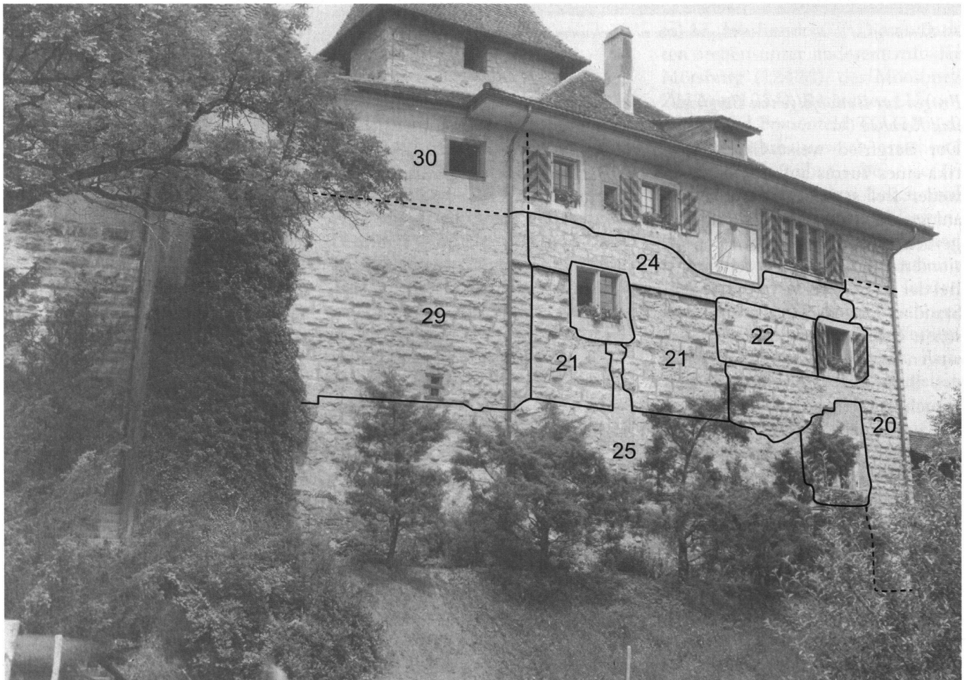
20: Südostfassade des Ostbaus. An den Kernbau Ost (20) mit den gegen Westen absinkenden Steinlagen schliesst sich die erneuerte Mauer (21) an, die sich gegen aussen neigt. Mit der Reparatur (22), der Aufstockung (24) und der Unterfangung (25) fassen wir spätere bauliche Veränderungen. Ins 13./14. Jb. datiert die ebenfalls nach aussen geneigte Schildmauer (29).
