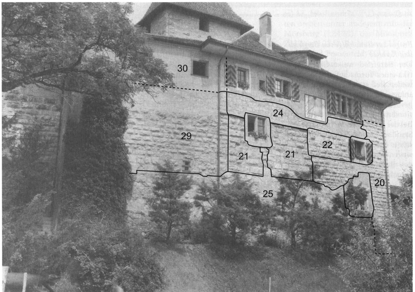
20: Südostfassade des Ostbaus. An den Kernbau Ost (20) mit den gegen Westen absinkenden Steinlagen schliesst sich die erneuerte Mauer (21) an, die sich gegen aussen neigt. Mit der Reparatur (22), der Aufstockung (24) und der Unterfangung (25) fassen wir spätere bauliche Veränderungen. Ins 13./14. Jh. datiert die ebenfalls nach aussen geneigte Schildmauer (29).
