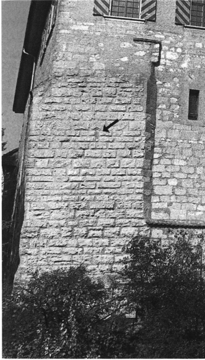
25: Ausschnitt der Südostfassade des Südwestbaus mit dem Kernbau Süd (32), der eine zugemauerte Rundbogenluzide (Pfeil) enthält. Einige der obersten Buckelquader zeigen Zangenlöcher. Der Kernbau Süd ist von der 1472 erneuerten Wand des «Ritterhauses» umgeben.
