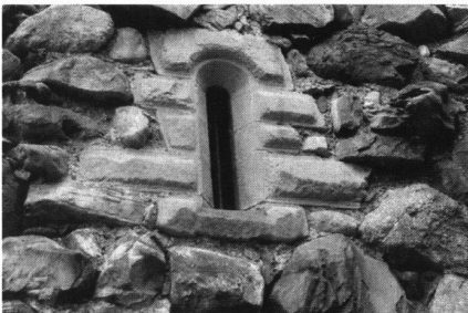
15: Rundbogenluzide am Wohnturm von Mammertsbofen TG, zwischen 1230 und 1240 errichtet.
