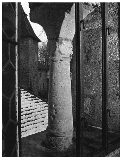
48: Das Doppelfenster des zwischen 1424 und 1480 errichteten Kapellenturms enthält eine wohl in Zweitverwendung eingesetzte romanische Säule.
