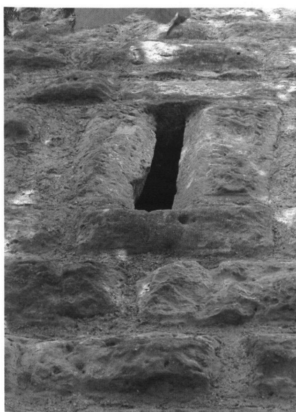
26: Ausschnitt der Südwestfassade des Kernbaus West (33). Inmitten des Buckelquaderwerks befindet sich ein rechteckiges Schlitzfenster.
