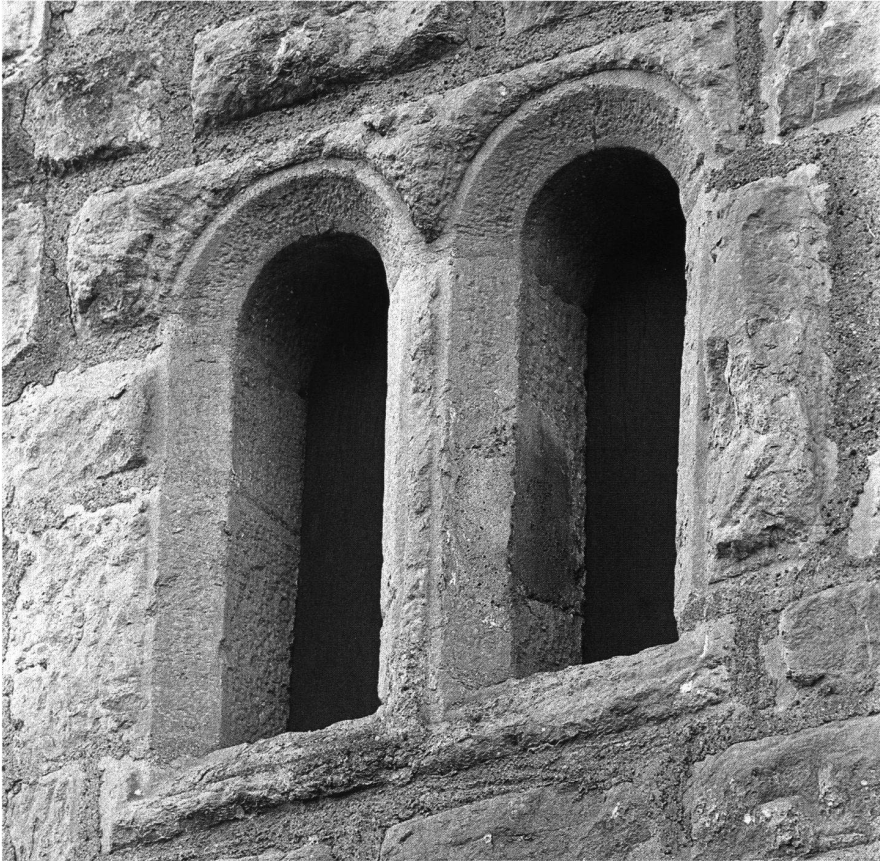
14: Die Doppelrundbogenfenster am Kernbau Ost zeichnen sich durch umlaufende, breite Schrägfasen aus, wie das einzige im originalen Zustand erhaltene Beispiel zeigt. Vergleiche weisen auf eine Datierung ins zweite Viertel des 13. Jb.s.
