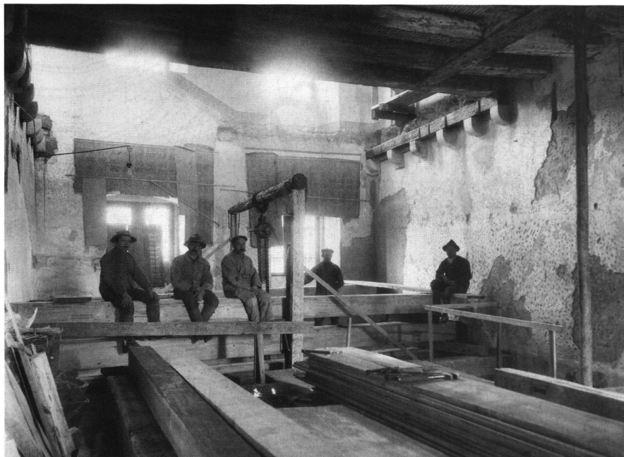
5: Beim Umbau von 1927 ersetzte man im Mitteltrakt des «Ritterhauses» die Böden.
