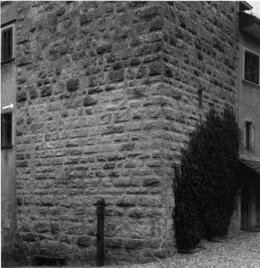
17: Beim Bergfried ist der Wechsel von längenbetonten zu höhenbetonten Buckelquadern besonders gut sichtbar.
