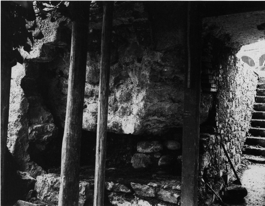
23: Die Pforte unter der Schildmauer während der Renovation 1926. Deutlich ist das auf die Erde gestellte Fundament der Schildmauer zu sehen, dem in der Neuzeit eine grabenseitige Vormauerung vorgesetzt wurde.
