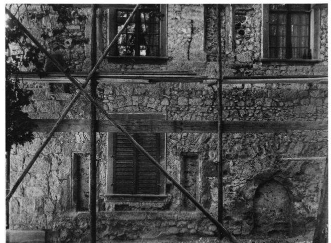
29 und 30: Die hofseitigen Fassaden des «Ritterhauses» während der Renovation 1926. Vor allem im Bereich der Ecke sind die zugemauerten Rechteckfenster des 14. Jb.s. zu sehen. Das Mauerwerk zeigt einen sehr einheitlichen Charakter.
