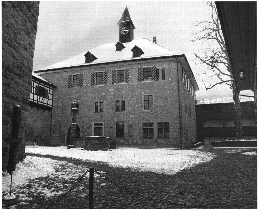
47: Ansicht des «Ritterhauses» von Nordosten. Dieses die Südwestecke der Burg dominierende Bauwerk entstand entweder in der ersten Hälfte des 14. Jb.s oder 1370.
