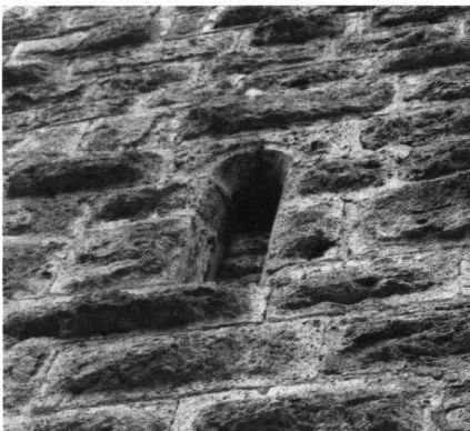
16: Rundbogenluzide am Wohnturm von Kastelen LU, kurz nach 1252 datiert. Beide Fenster sind aufgrund der Fertigung, namentlich der breiten Abschrägung der Kanten, gut mit den Doppelrundbogenfenstern der Kyburg vergleichbar.
