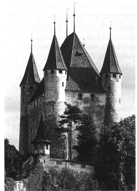
12: Thun, Schloss, bausteinerne, unten runde, im obersten Geschoss polygonale Türmchenaufsätze und Walmdach anstelle einfacherer Abschlüsse, um 1430/36 durch den Stand Bern erbaut.
