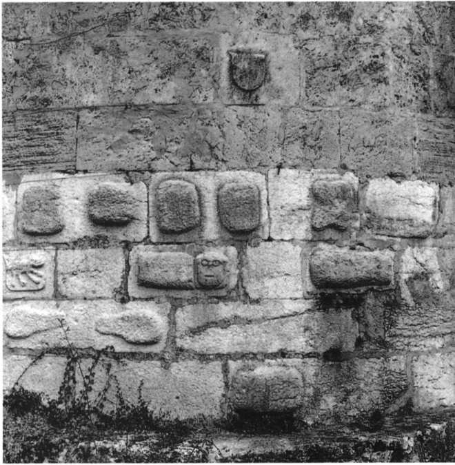
13: Erlach, Schloss, Hauptturm, erbaut in den letzten Jahren des 15. Jahrhunderts, Sockel, Kalkstein. Holligen, Schloss, Wobnturm, erbaut um 1509, Eckerband, Sandstein. Im späten 15. und im frühen 16. Jahrhundert tauchen «romanisierende» Elemente in der gebauten und gemalten Architektur, aber auch in der Formierung von Bossenquadern auf.
