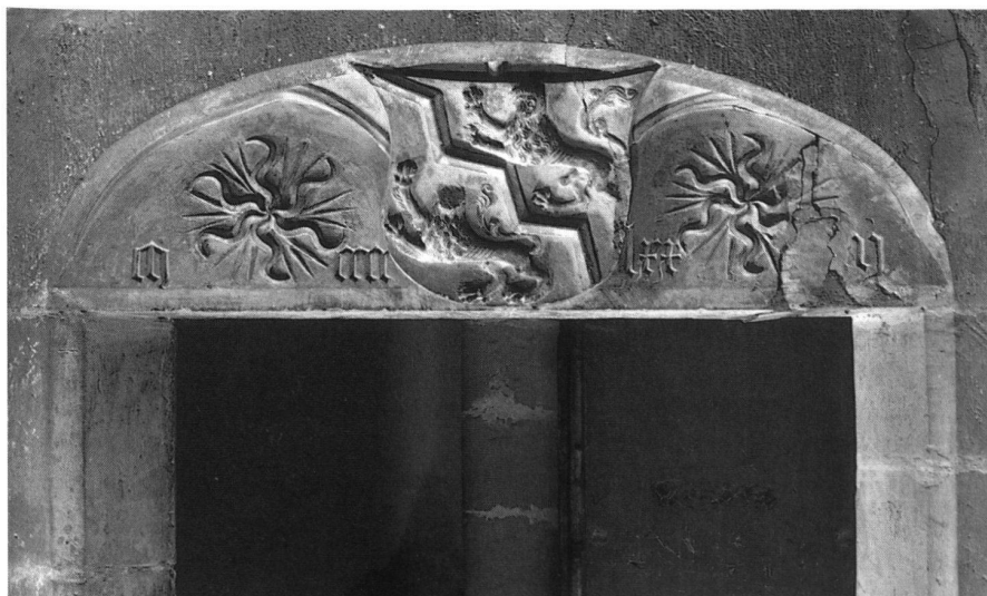
7: Worb, Schloss, Treppenturmportal im Zugangsgeschoss mit ausschwingender Freitreppe; Detail: Türsturz datiert 1472 mit Wappen von Diesbach zwischen Sonnenrädern.
