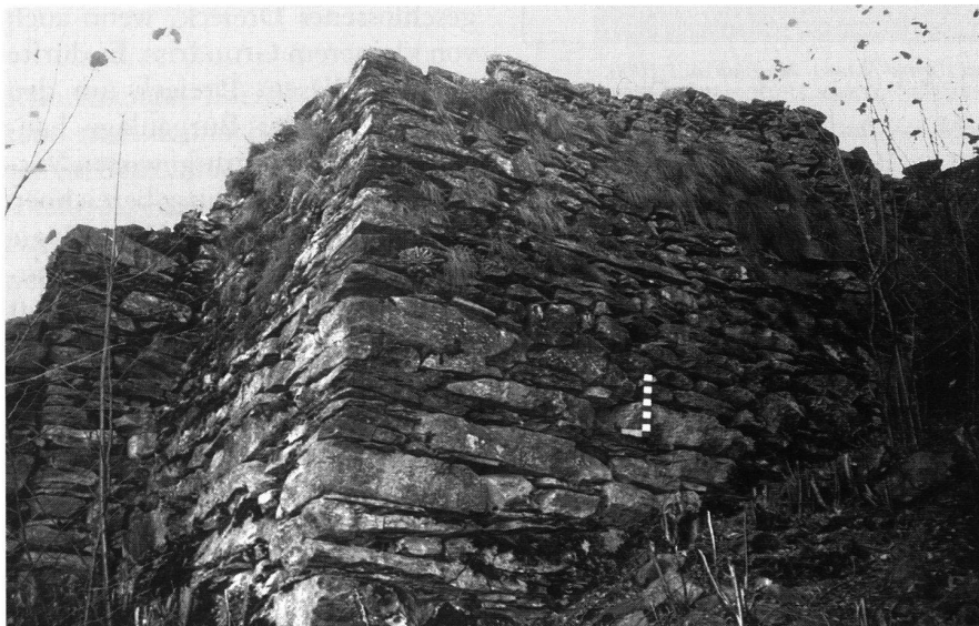
11: Caslasc, Eskarpe von Norden. Ganz links am Bildrand die Trennfuge zwischen M2 (links) und M3 (rechts).
