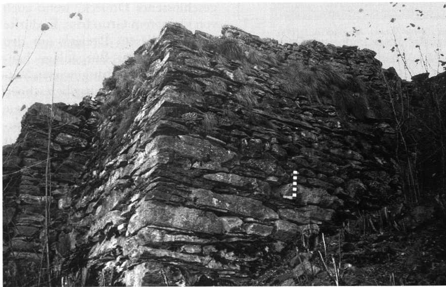
11: Caslasc, Eskarpe von Norden. Ganz links am Bildrand die Trennfuge zwischen M2 (links) und M3 (rechts).
