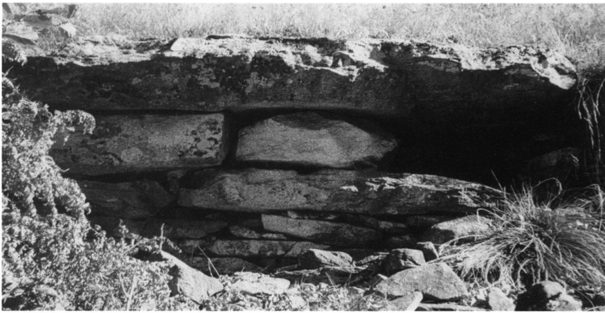
20: Der Caslasc von Grumo (Gde. Chironico), Ansicht der Westmauer. Auch hier besteht das Mauerwerk aus grossen, sorgfältig geschichteten Steinplatten.
