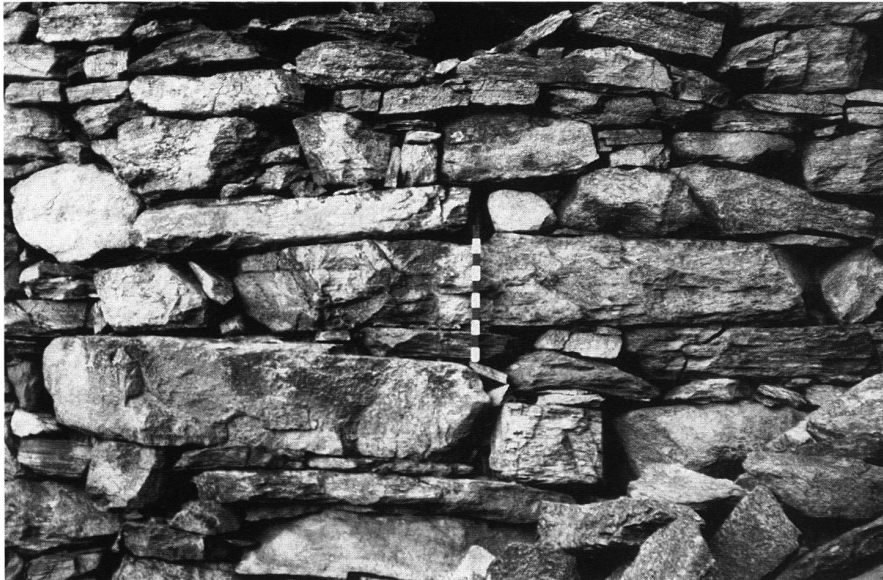
14: Detailaufnahme der grössten Granitplatten in der Orsino-Mauer (Länge des Massstabes 50 cm).
