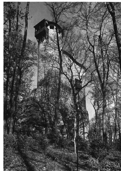
3: Burg Reichenstein (Arlesheim, BL), Zustand nach dem Wiederaufbau.
