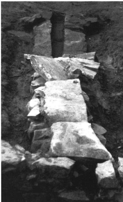
8: Kanal der Heizungsanlage. Sicht von Norden.
