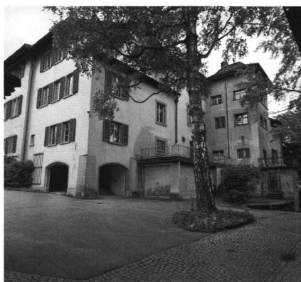
12: Nordfassade der Kernanlage mit Abortturm 1999. Er entstand in seiner heutigen Form im späten 19. Jahrhundert; er wurde dabei gegenüber seinem Vorgänger um rund 2 m zurückgenommen. Der eingeschossige Anbau auf der Nordseite zeigt in etwa seine ursprüngliche Grundrissaussdehnung nach Norden.
