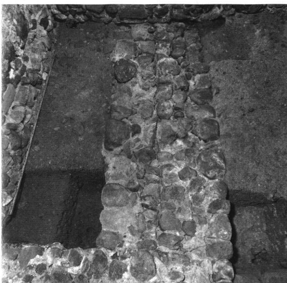
5: Die Ringmauer der ersten Anlage mit etwas jüngerer, südseitiger Vormauerung. Blick nach Westen.
