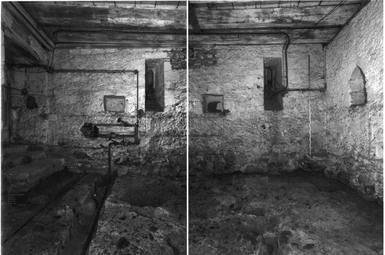
10: Der Keller des Saalgeschosshauses. Blick nach Osten mit Eingangstür, Lichternischen und schlitzartigen Spitzbogenfenstern.
