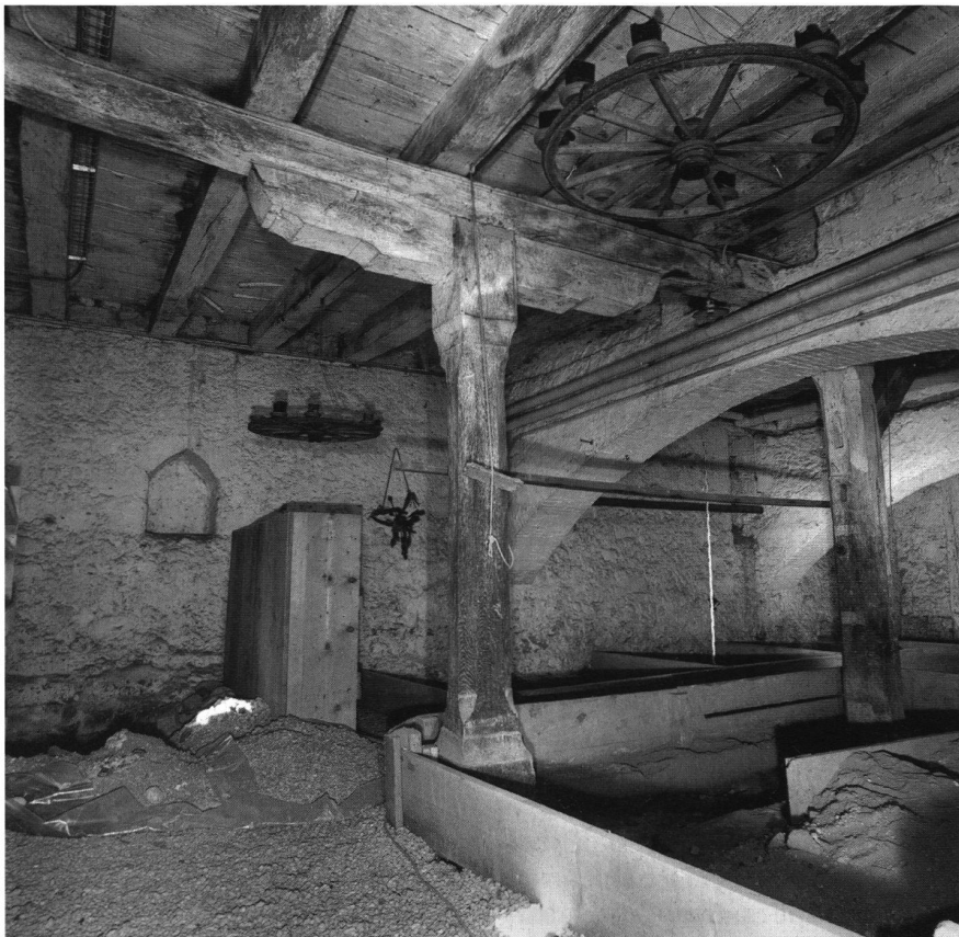
8: Der Keller des Saalgeschossbaues. Sichtbar ist die originale Geschossbalkenlage mit zugehörigem Unterzug und Stütze im Hintergrund. Die Stütze im Vordergrund ist nachträglich, ebenso die beiden Schwibbögen aus Backstein. Blick nach Südwesten.
